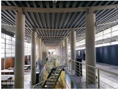
Pasillo central, escaleras a primer nivel y cubierta.
