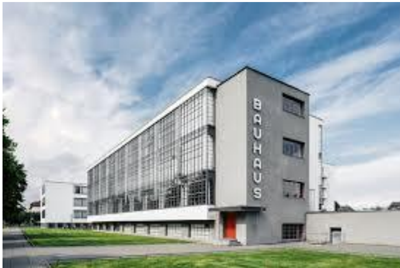
Vista del edificio de talleres.
