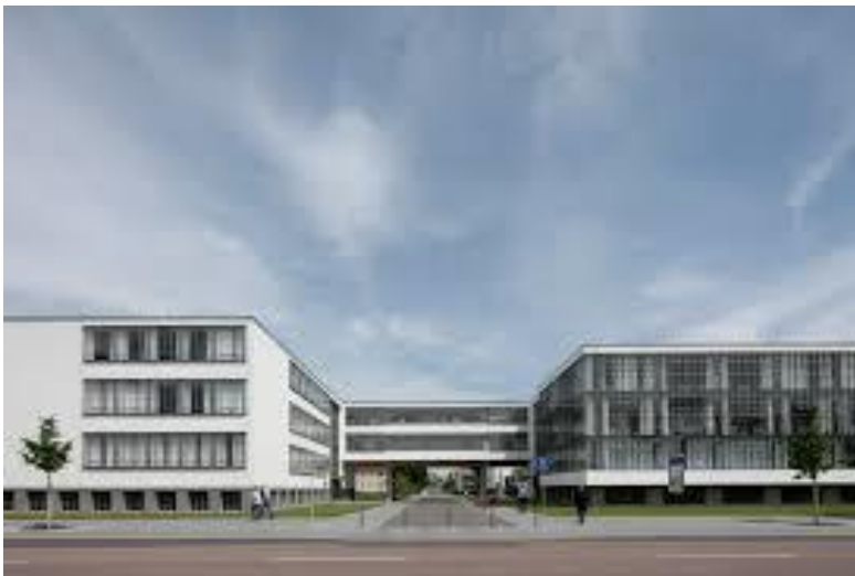
Vista de escuela técnica, paso a desnivel, administración y talleres.
