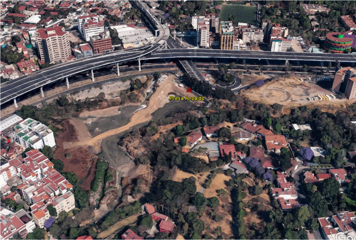
Figura 3.2. Presa Anzaldo en Google Earth.
