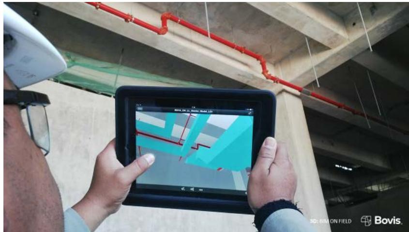
Ilustración 24 Supervisión de obra revisando en el modelo BIM / Fuente: Bovis
