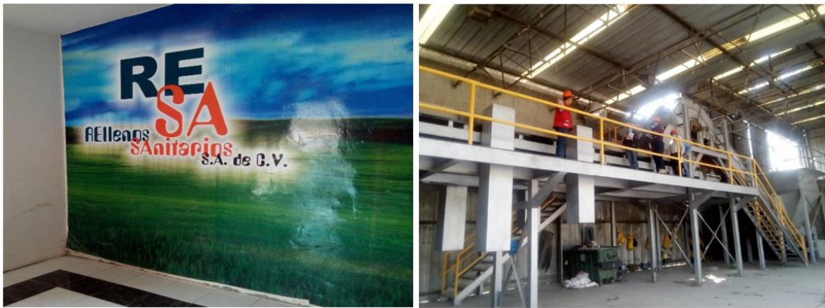
Figura 5.24 Instalaciones relleno sanitario Puebla, RESA
