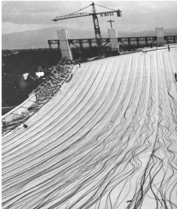
Cubierta con tensores/ Alberca Francisco Márquez
