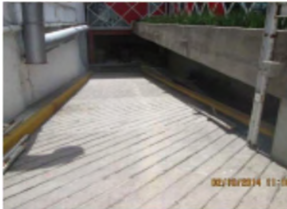
Rampa de acceso a cuarto de máquinas/ Gimnasio de clavados
