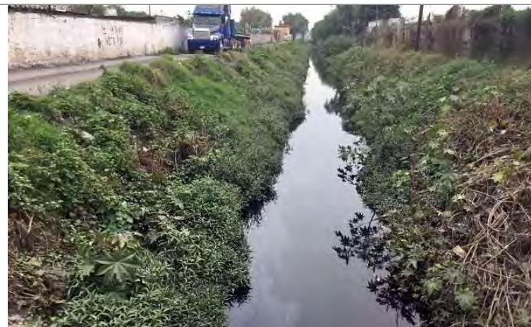
Canal de aguas negras Tultitlán 2018
