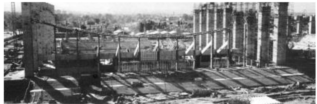
Construcción de cubierta / Alberca Francisco Márquez
