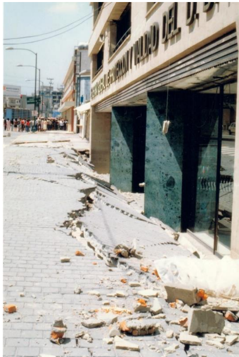
Figura 1. Daños a un edificio de la Ciudad de México ocasionados por el sismo de 1985 (cortesía de Díaz-Rodríguez)
