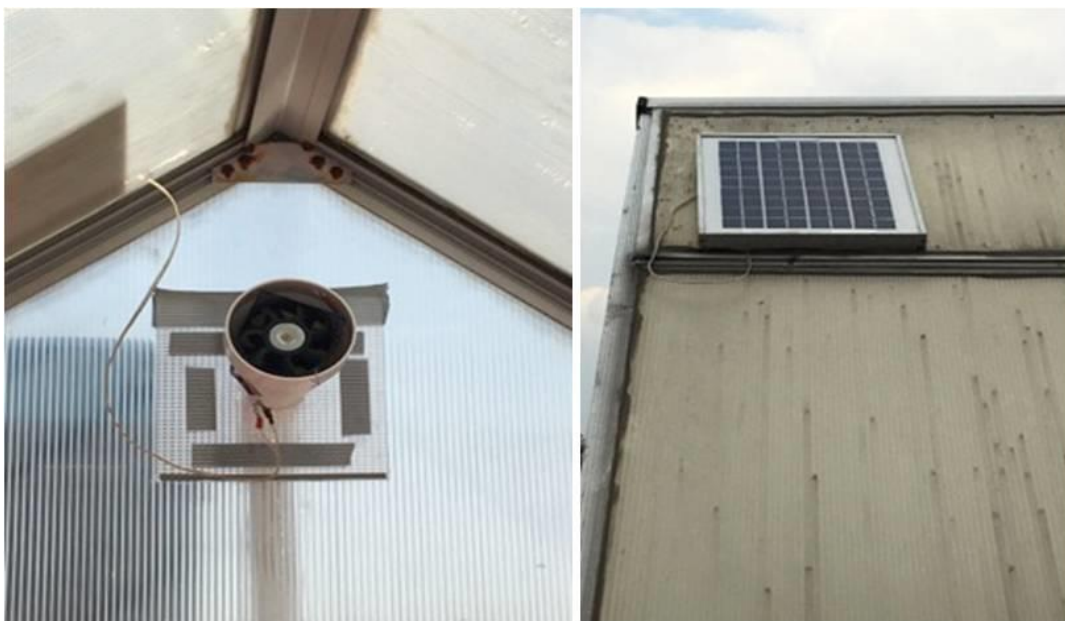
Figura 3.19: Extractor de la caseta (derecha) y Celda solar (izquierda).
