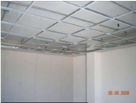
OBRAS INTERIORES: SOPORTARÍA PARA PLAFÓN MODULAR
