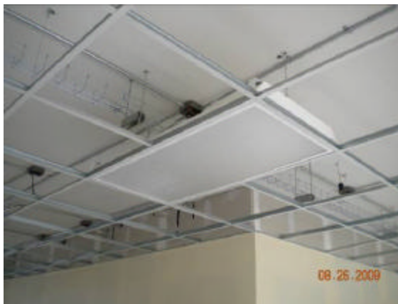
COLOCACIÓN DE LUMINARIAS EN PLAFÓN MODULAR
