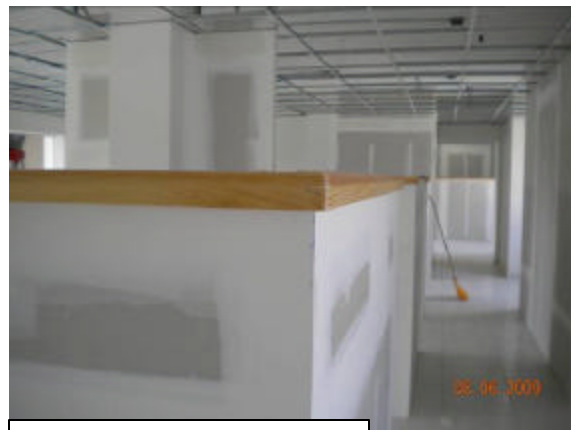
OBRAS INTERIORES: MUROS DE TABLAROCA Y REMATES DE MADERA
