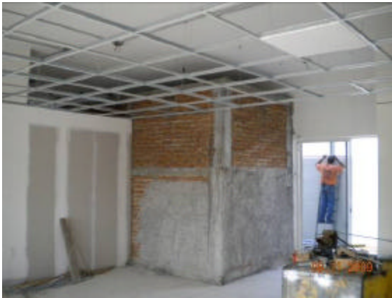
FABRICACIÓN DE CUARTO DE SITE (INTERCOMUNICACIÓN DE VOZ Y DATOS)
