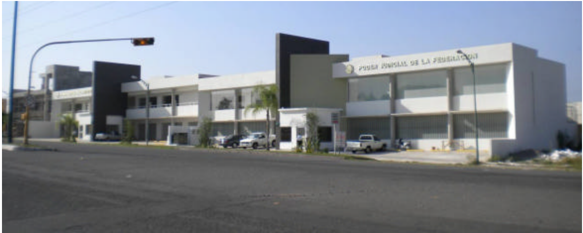
TERCER ANILLO PERIFERICO NOS. 672 Y 680, COLIMA, COLIMA FACHADA PRINCIPAL
