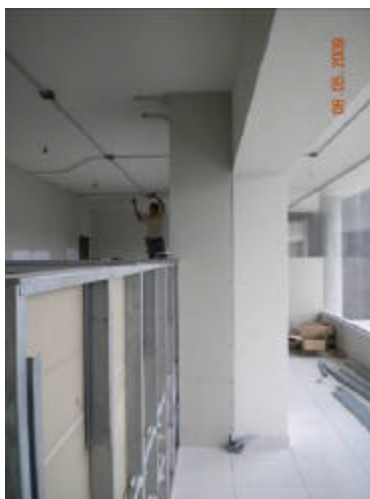
MUROS DE TABLAROCAY SOPORTARÍA PARA PLAFONES
