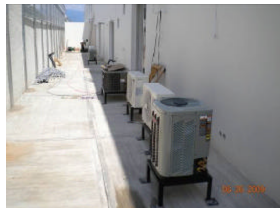
INSTALACIÓN DE CONDENSADORAS (EQUIPO DE AIRE ACONDICIONADO)
