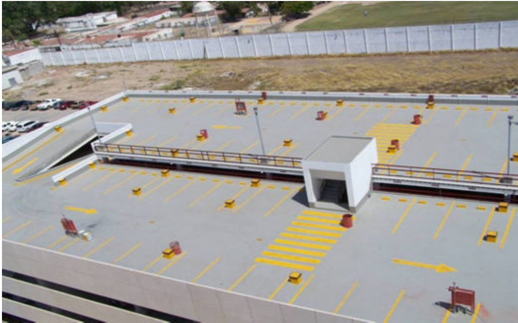
EDIFICIO SEDE DEL PODER JUDICIAL DE LA FEDERACIÓN CULIACAN AZOTEA DE ESTACIONAMIENTO
