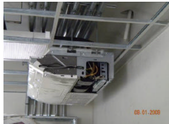
INSTALACIÓN DE EVAPORADORAS
