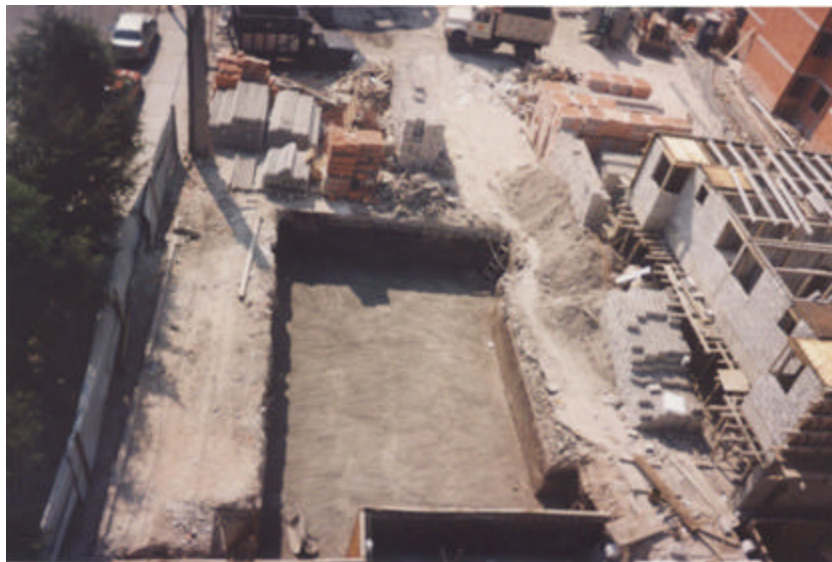
EXCAVACIONES PARA CAJÓN DE CIMENTACIÓN
