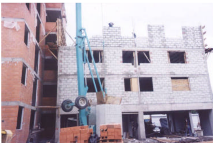
MUROS DE BLOCK EN TERCER NIVEL
