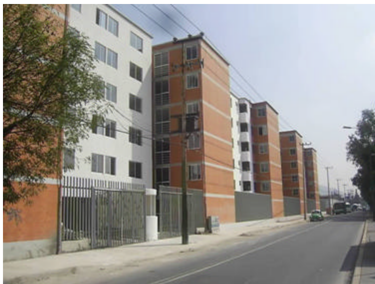
INSURGENTES SUR NO. 1190 FACHADA PRINCIPAL
