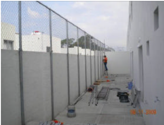
COLOCACIÓN DE MALLA CICLON EN PATIO POSTERIOR
