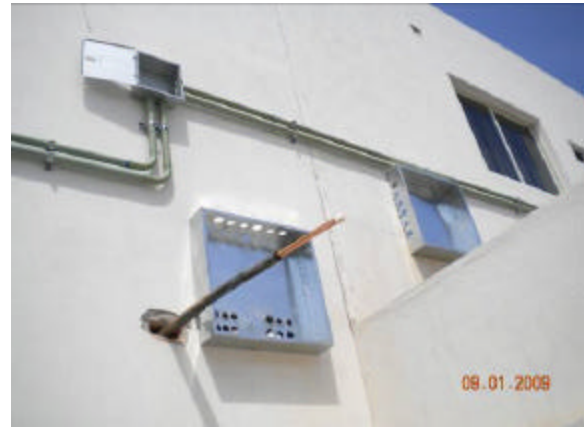
COLOCACIÓN DE GABINETES ELECTRICOS Y DE VOZ Y DATOS EN FACHADA POSTERIOR
