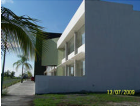
FACHADA LATERAL Y FRONTAL
