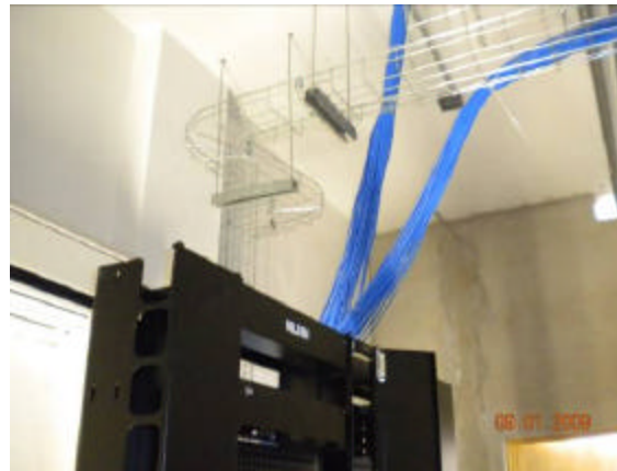
CABLEADO DE RACKS EN SITE (INSTALACIÓN DE VOZ Y DATOS)
