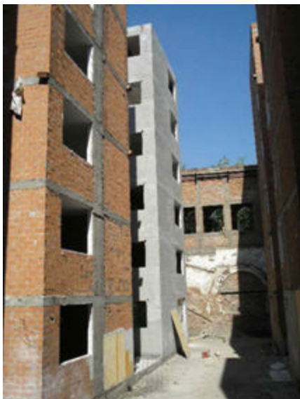
FRAY SERVANDO NO. 237 FACHADAS INTERIORES
