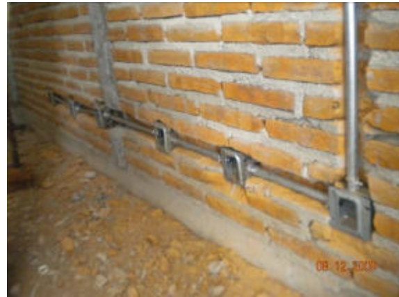
PREPARACIONES ELÉCTRICAS EN SITE
