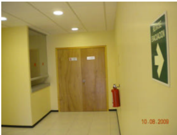
SEÑALIZACIÓN Y EXTINTORES
