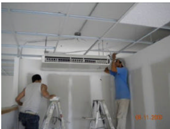
INSTALACIÓN DE EVAPORADORA (EQUIPO DE AIRE ACONDICIONADO)
