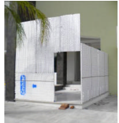
OBRAS EXTERIORES: CASETA DE ACCESO
