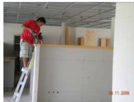
COLOCACION DE REMATES DE MADERA EN MUROS BAJOS DE TABLAROCA
