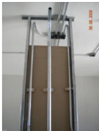
PREPARACIONES PARA INSTALACIONES ELÉCTRICAS EN INTERIOR DE MUROS
