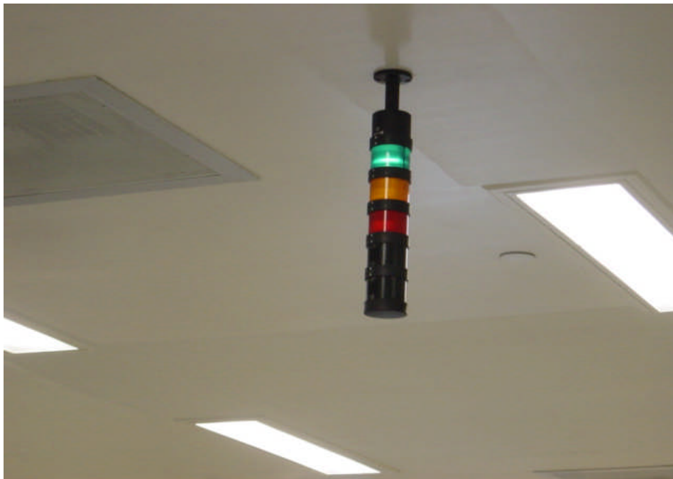
Esquema 4. Semáforo: Este indicador funciona como un semáforo vial, al prenderse la luz roja, indicara que existe alguna presión fuera del límite. Y permanecerá en verde cuando todo este en especificación.
