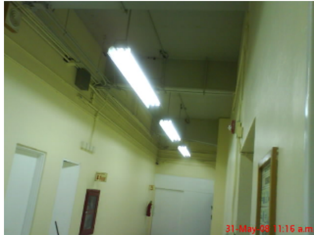
Fig. 1.7 lámpara fluorescente 2 X 75 Watts
