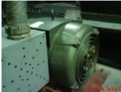
Fig. 2.10 motor de ventilador de inyección
