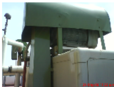
Fig. 2.23 motores de manejadoras
