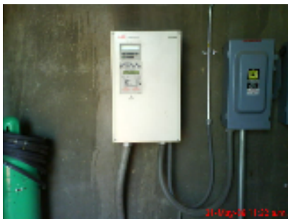
Fig. 4.2 Variadores de frecuencia para manejadoras. (derecha fuera de servicio)
