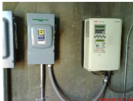
Fig. 4.2 Variadores de frecuencia para manejadoras. (derecha fuera de servicio)
