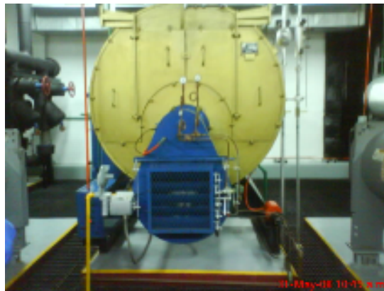
Fig. 2.7 caldera o generador de vapor
