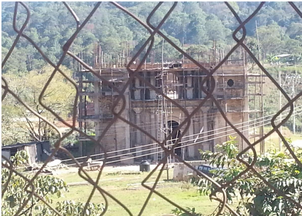
Foto 1. Iglesia en construcción, comunidad triqui de Rio Venado. Fotografía: Iriana Ayala. Fecha de captura 29 de noviembre de 2013.
