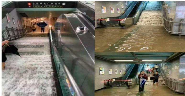
Figura 2.2.4 Inundación en el metro de Guangzhou
