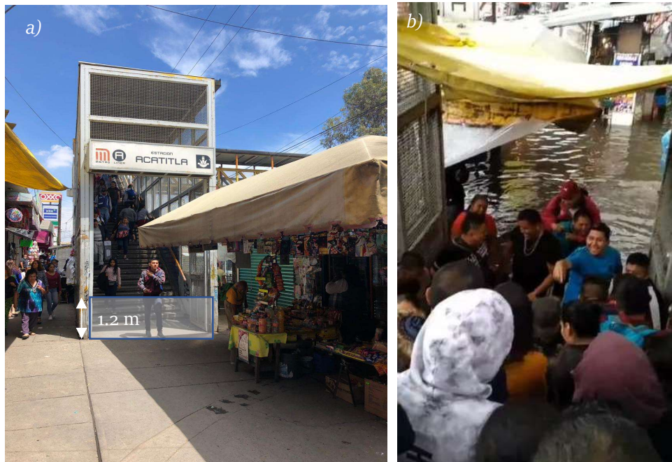
Figura 5.3.3 a) Propuesta en acceso a la estación Acatitla b) Falla
