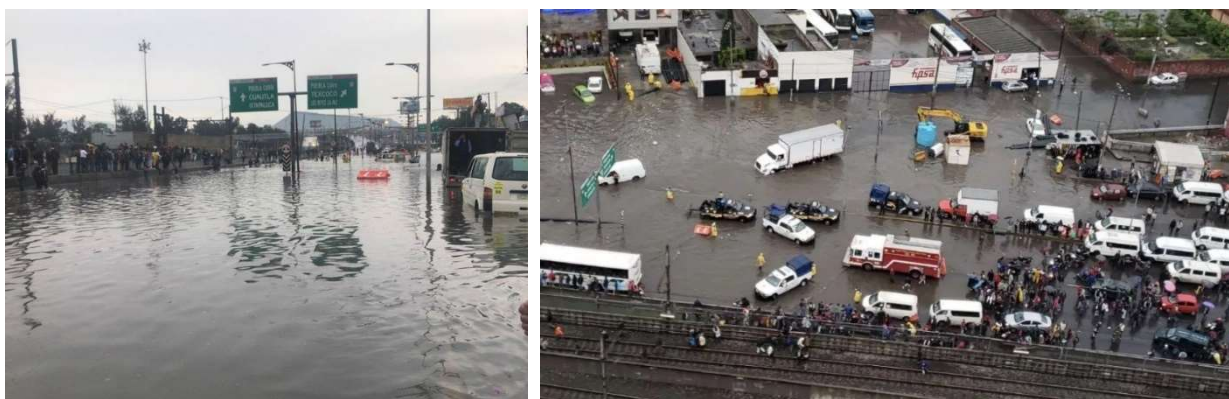
Figura 4.3.13 Inundación en acceso al Puente La Concordia
