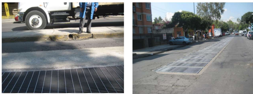
Figura 4.2.4 Rejillas de ventilación a nivel superficial
