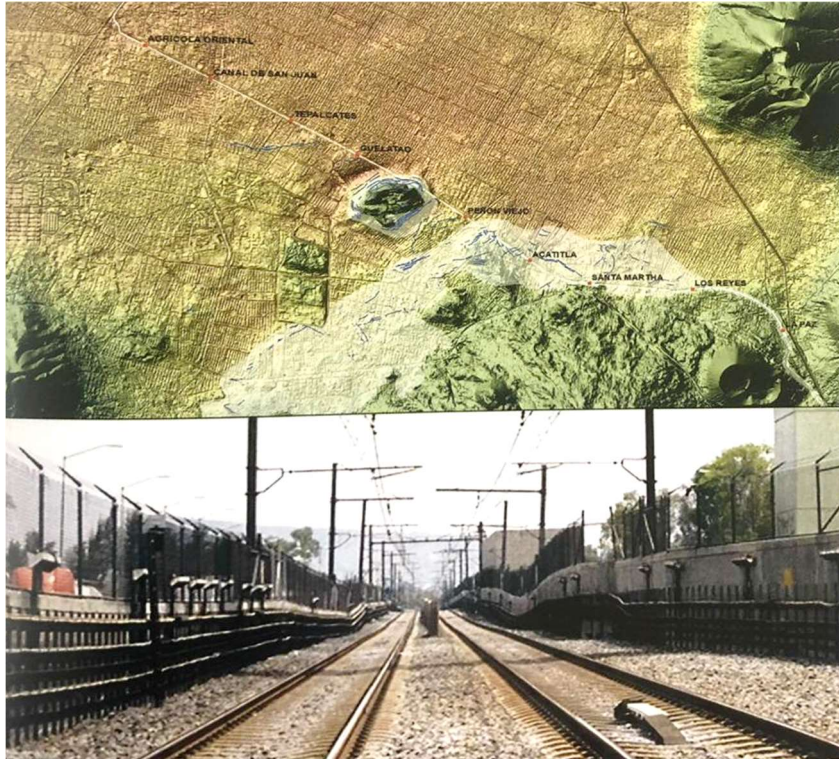
Figura 4.1.2 Deformaciones diferenciales en Línea A del S.T.C. Metro Fuente: El subsuelo de la Ciudad de México Vol. III (Auvinet et al., 2017)
