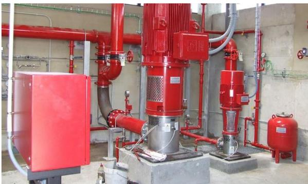
Este es un equipo de bombeo, es el encargado de llevar el agua a presión por las tuberías instaladas en la tienda de autoservicio, en caso de incendio, este se activa y dispersa por medio de los rociadores, el agua.
