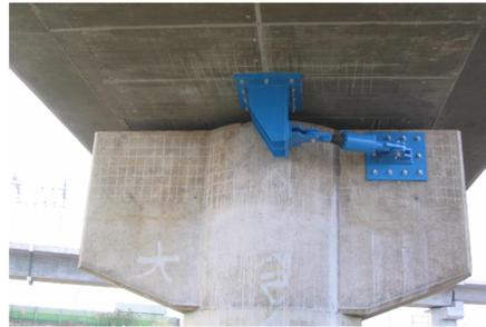
(b) Amortiguador viscoso instalado transversalmente en el Puente Dong-Yun, Corea del Sur
