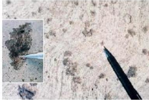
Fig. 2-10. Erupciones causadas por RAS de partículas del tamaño de la arena. La foto interna enseña un primer plano de la erupción
