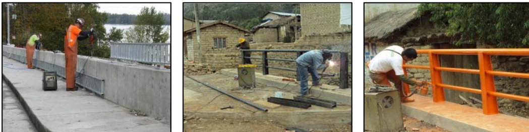
Figura 2.7-2. Reparación de parapetos metálicos. (J.V.S Web y Sellwoodbridge Web)
