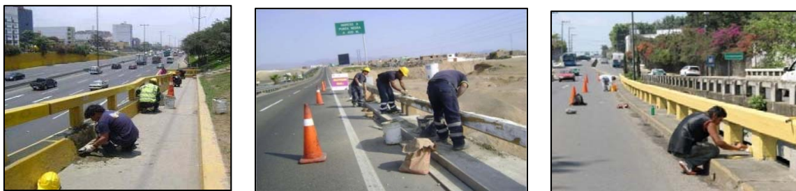
Figura 2.7-1. Reparación de parapetos. RPP Noticias web, Andina web.
