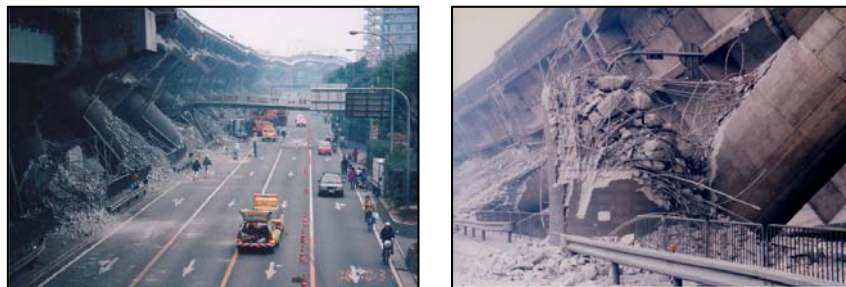
Figura 1.4-19. Colapso del viaducto Fukae, sismo de Kobe 1995. (Amini, Taghikhani y Yavari, 2010)
