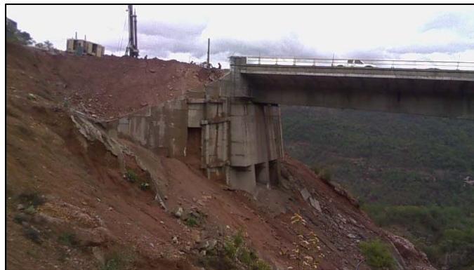
Figura 5.2-5. Movimiento de tierras para el acomodo del terraplén de acceso. (Rivera, 2017)
