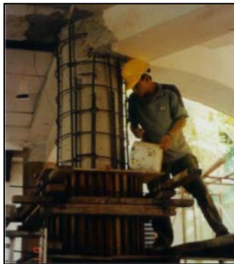
Figura 3.3-2. Rehabilitación de una columna con encamisado de concreto. (Chhabra, 2004).
