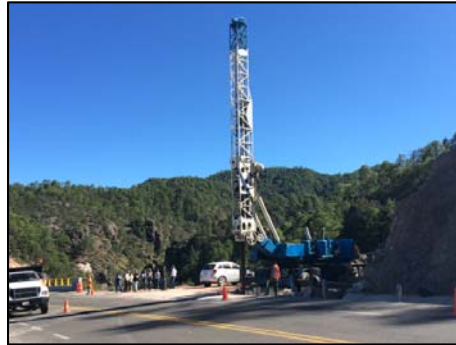
Figura 5.2-6. Inyección de mortero fluido en el volumen del relleno. (Rivera, 2017)
