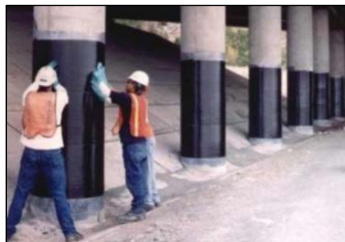
Figura 3.3-9. Encamisado de columnas con FRP. (Jara, 2011).
