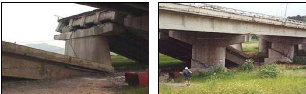
Figura 1.4-27. Vista general del puente sobre el río Wu. La falla cruzó el puente y provocó el desplome dos tramos de superestructura. (Tomado de Berkeley.edu)
