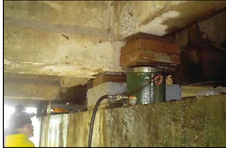
Figura 4.3-1. Levantamiento de tableros a base de gatos hidráulicos.
