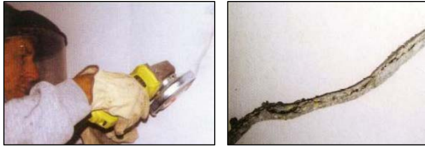
Figura 2.3-3. Perfilado de grieta con disco diamante exponiendo superficie nueva. (Trout, 2005)
