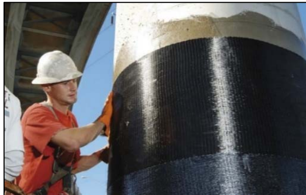
Figura 5.3-2. Columna de concreto rehabilitada por medio de un encamisado de fibra de carbono. (Fibraplus, 2018)
