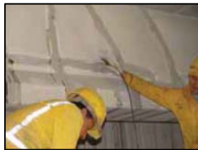
Figura 2.4-3. Proceso de inyección de una resina epóxica a través de unas boquillas colocadas en la superficie de la fisura. (SIKA)
