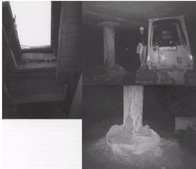
Fotografía 3.2 Excavación top-down (Hospital Beth Israel Deaconess, Boston)
