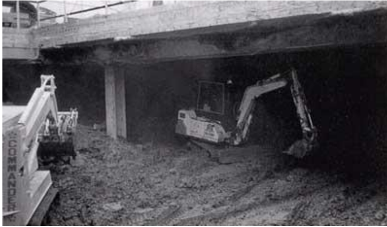
Fotografía 3.1 Excavación top-down (Hospital Beth Israel Deaconess, Boston)
