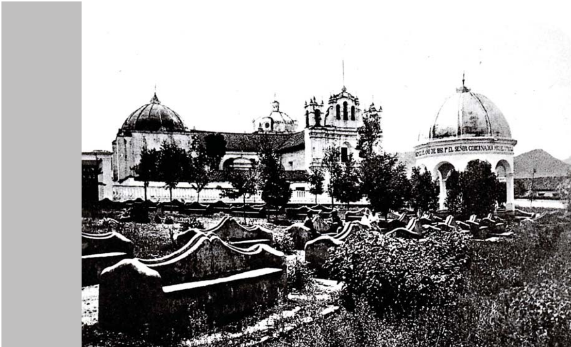
FIG. 6. TEMPLO DE LA CARIDAD. PLAZA Y KIOSCO EN 1884. Construcción de plaza durante el gobierno de Miguel Utrilla.
