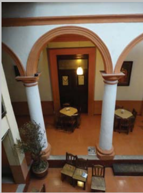
Columnas de capitel toscano, arcos de medio punto.
