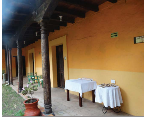
FIG. 68 COLUMNAS DE MADERA Y ALEROS EN PATIO DE CASA DE PRINCIPIOS DEL SIGLO XIX. Fotografía Ana V. López, 2014.
