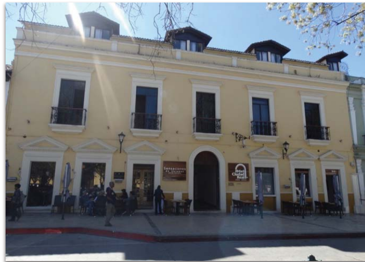
FIG. 36 CASA EN PLAZA 31 DE MARZO NO. 10.- Fotografía del autor, 2014
