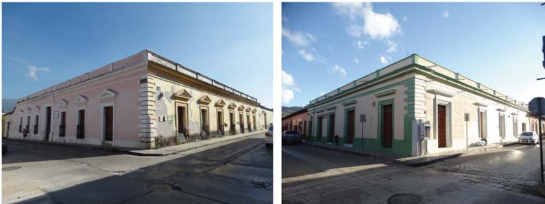
FIG. 26 VISTAS DE LAS FACHADAS DE LA CASA "LA ENSEÑANZA"
