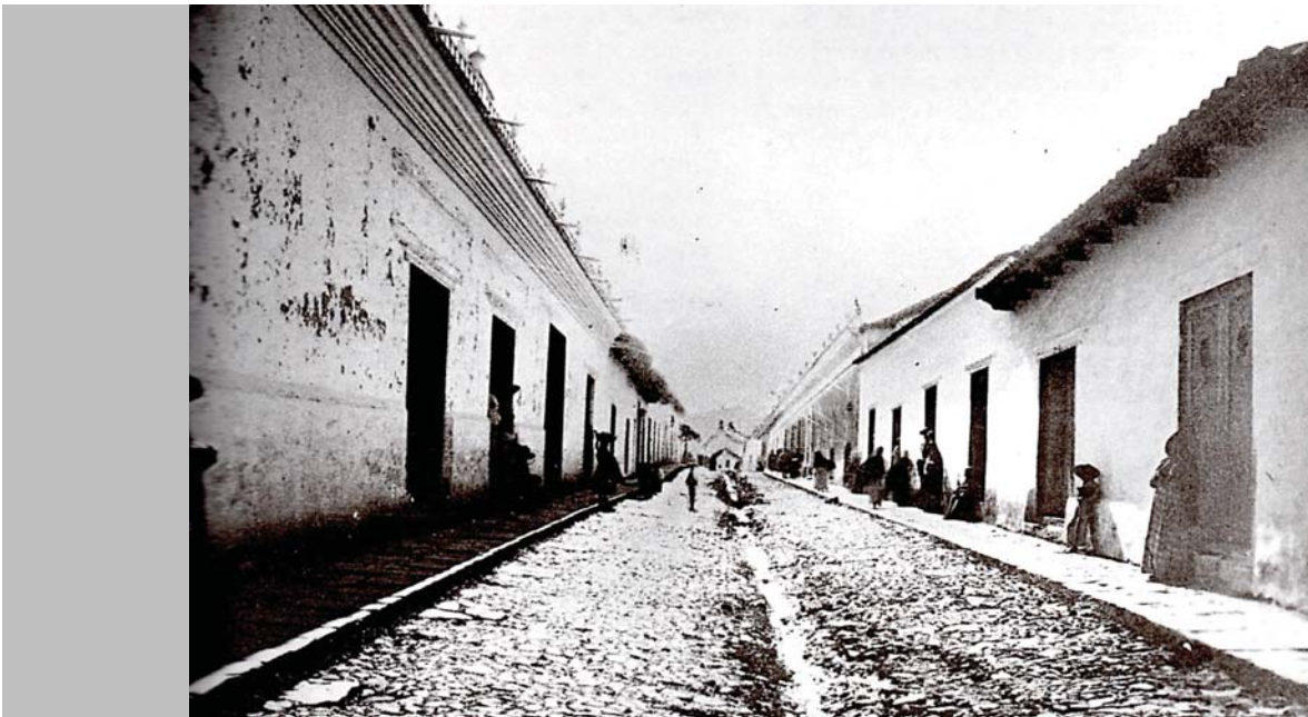
FIG. 5. CALLE REAL DE GUADALUPE EN 1884. Arquitectura popular: muros de adobe, cubiertas son teja y aleros de madera.
