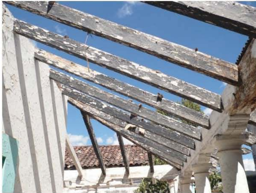
CUBIERTA DE ESTRUCTURA DE MADERA DE LA CASA "LA ENSEÑANZA".
