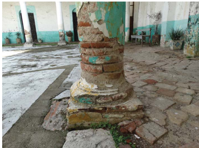
FIG. 69 COLUMNAS DE LADRILLO MEDIA LUNA. Sección B, escuela "La Enseñanza". Fotografía Ana V. López, 2013.
