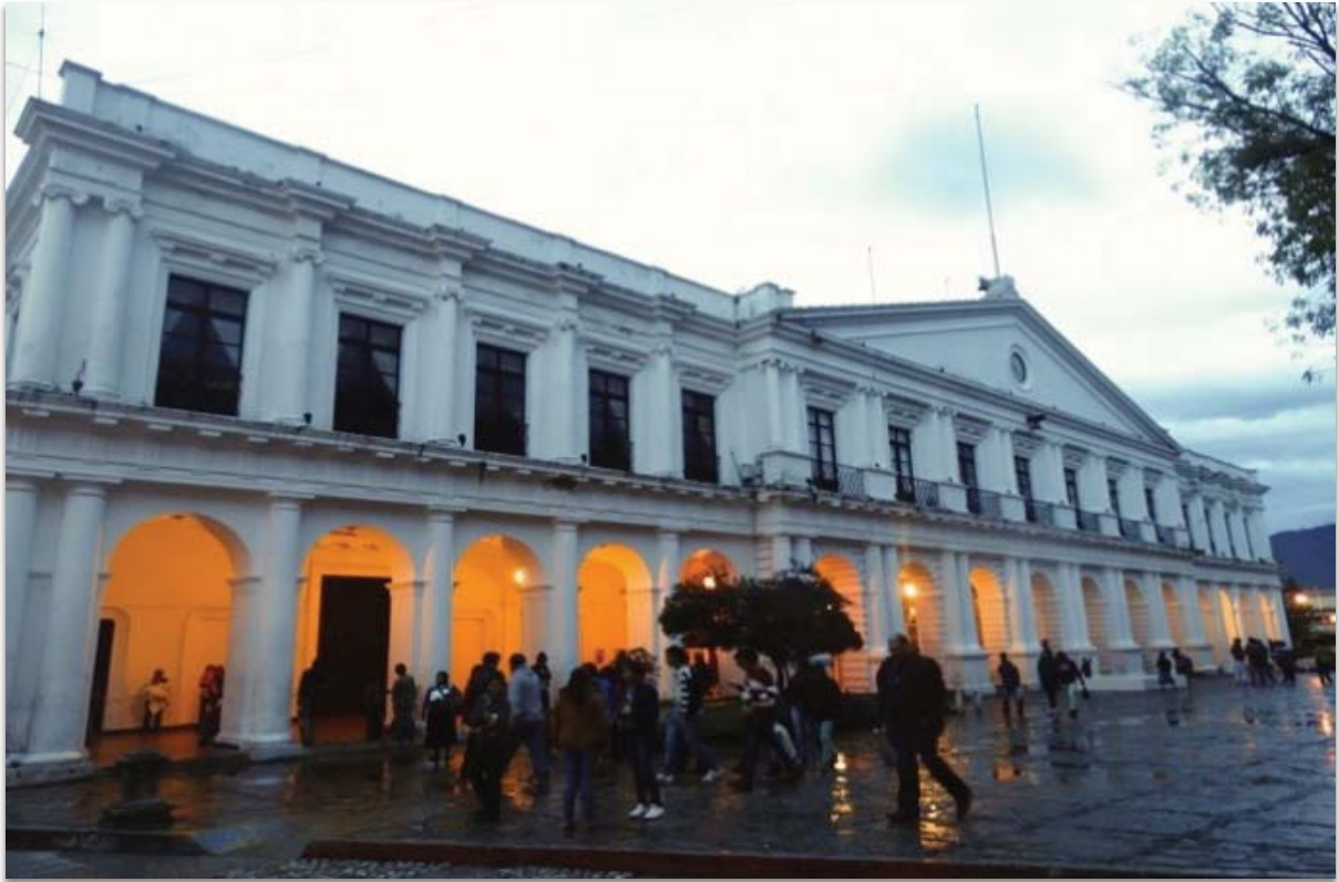
FIG. 10 FACHADA DEL AYUNTAMIENTO MUNICIPAL. Fotografía Ana V. López, 2014 Construcción en 1895. Pórtico toscano con pedestal y arcos con almohadillado en la sección central de la fachada con remate superior de un frontón.
