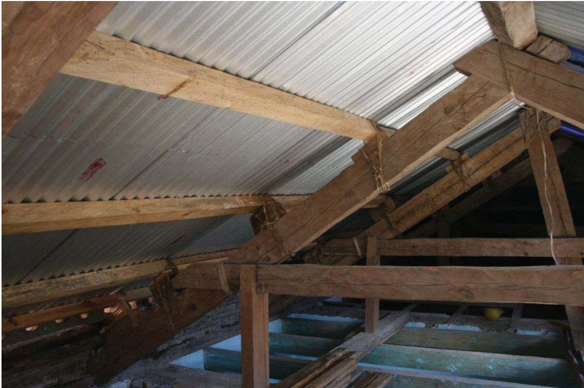
FIG. 64. ESTRUCTURA DE MADERA DE LA CUBIERTA EN LA SECCIÓN A. Fuente: Archivo fotográfico de "La Enseñanza", primera intervención en 2006.
