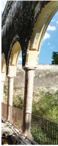
Columna de arcada hacia patio central
