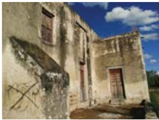
Vista lateral de la Capilla
