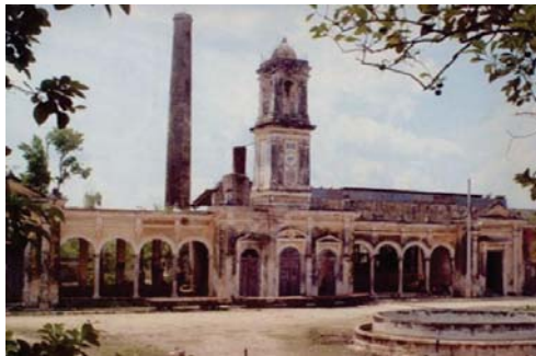
Imagen 12. Fachada Casa de Máquinas.
