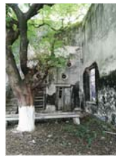
Escaleras hacia Azotea Casa Principal
