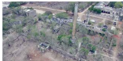
Vista aérea Fachada Posterior
