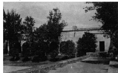
Imagen 9. Fachada de la Casa Principal, 1920.
