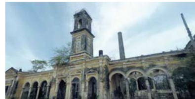
FOTOGRAFÍA 3 Vista Frontal de la torre de campanario
