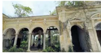
FOTOGRAFÍA 4 Vista exterior Casa de Máquinas
