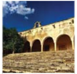
FOTOGRAFIA 2 Arcada de la Fachada
