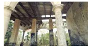
Detalle de estructura y losa Casa de Máquinas
