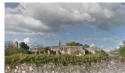
FOTOGRAFIA 6 Vista frontal de la Fachada
