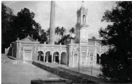
Imagen 10. Fachada de la Casa de Máquinas, 1920.
