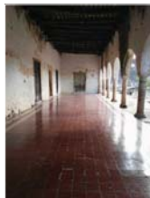
Corredor de acceso a Casa Principal
