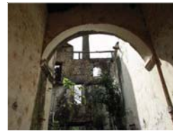
FOTOGRAFÍA 7 Vista interior administración
