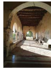
Acceso a la Capilla
