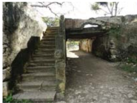
FOTOGRAFÍA 2 Vista de escaleras y pasillo
