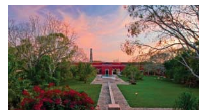
Imagen 48. Fachada Casa de Máquinas Hacienda Temozón Sur.
