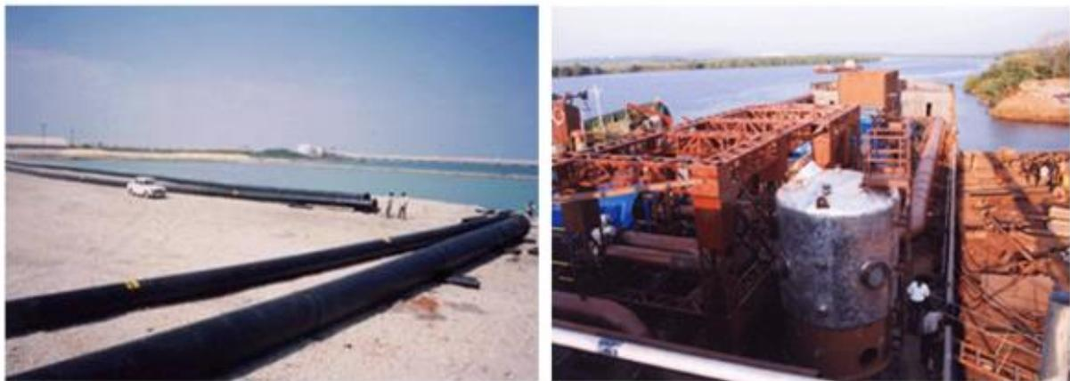
Figura 1.9 Detalles de la cubierta y el tubo de agua fría de la Figura 1.8. Planta OTEC de la India Sagar Shakti (Department of Ocean Development, 2011)
