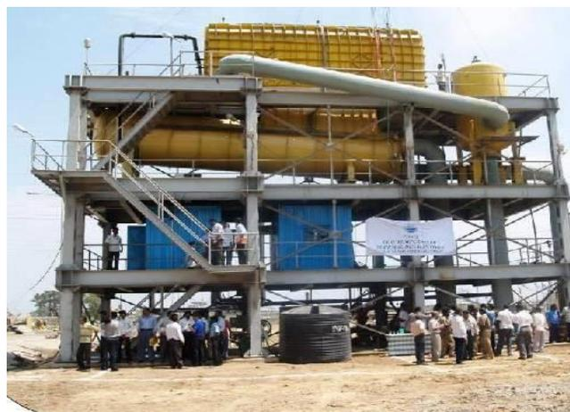
Figura 1.7 Planta OTEC-OC en Kavaratti produce 100m<sup>3</sup>/día ((NIOT), 2011)
