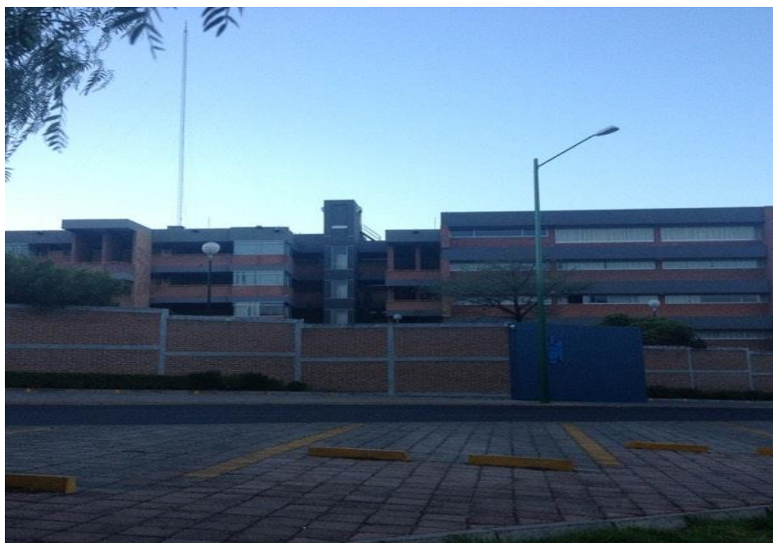
Fachada del Colegio Miraflores en León, Guanajuato. Boulevard Alonso de Torres
