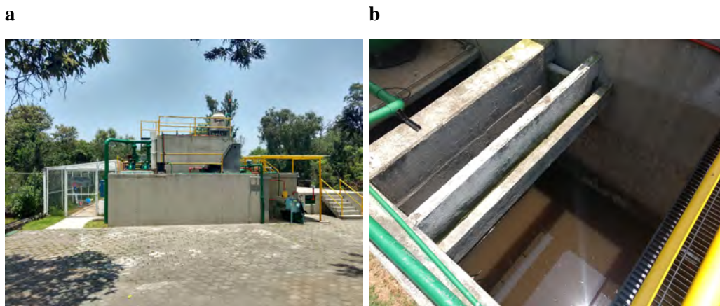
Figura 7.2. Planta de Tratamiento de Agua Residual Facultad de Ciencias Políticas y Sociales de la UNAM (a) y Tanque de almacenamiento del efluente secundario (b)
