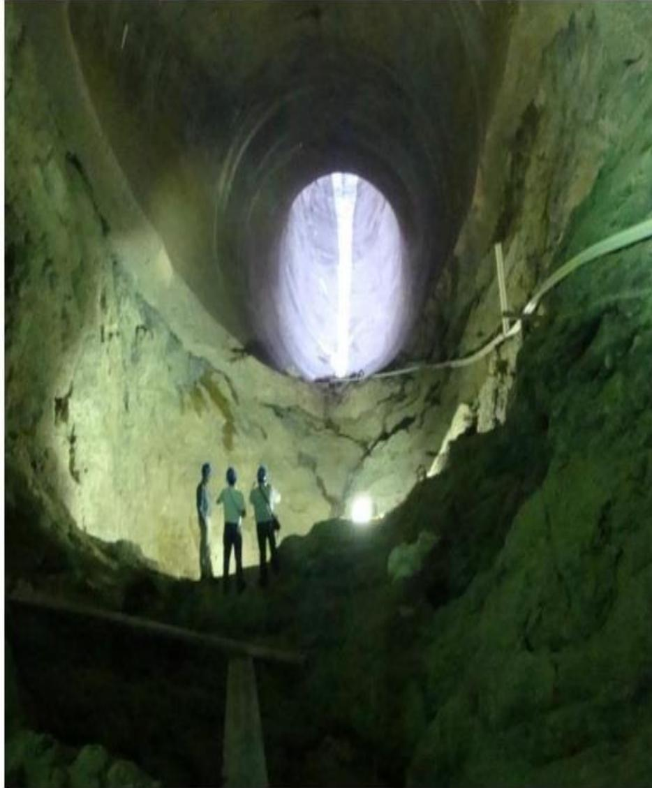
**Figura 3.8.** Daño por cavitación en uno de los túneles de la presa Infiernillo (Gómez Arteaga, 2016)
