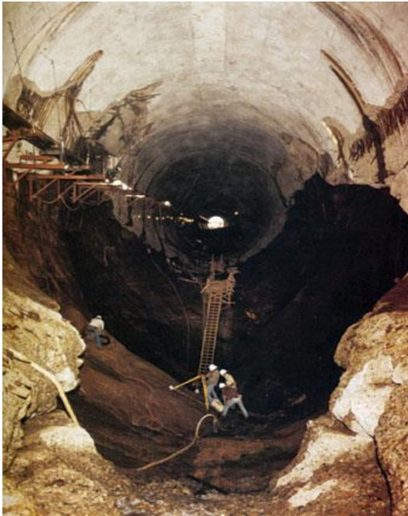
**Figura 3.6.** Daño por cavitación en el Túnel del vertedor de la presa Glen Canyon, Septiembre de 1983 (Falvey, 1990)
