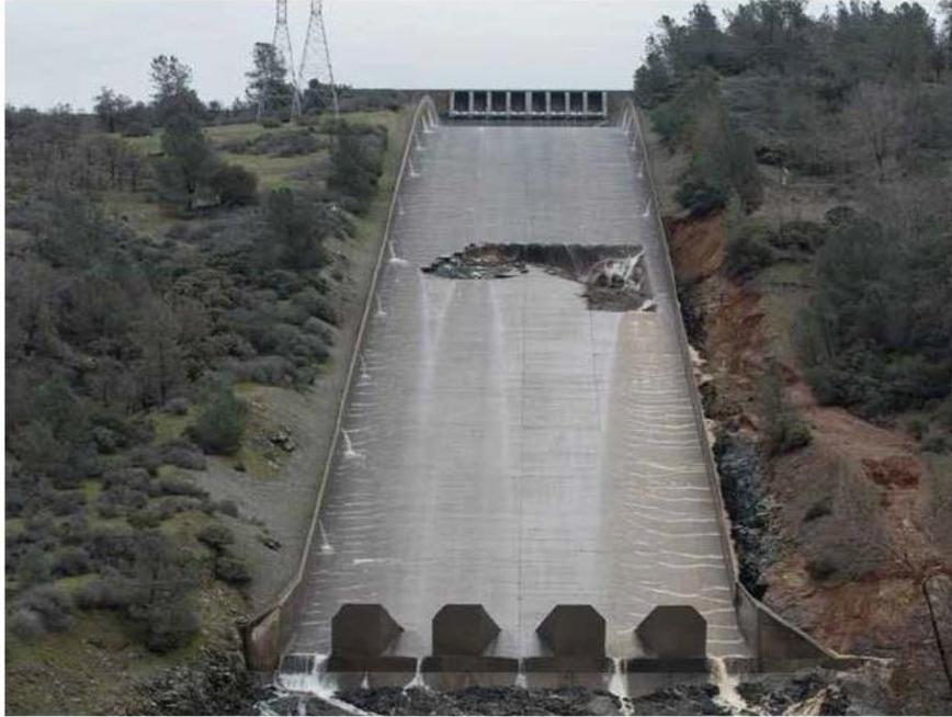
**Figura 3.9.** Daños por cavitación en la rápida del vertedor de la presa Oroville (Sandoval Erazo, 2018)
