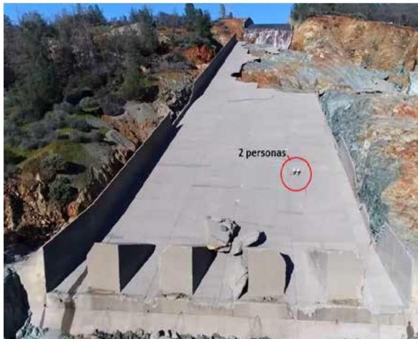
**Figura 3.10.** Inspección de los daños, debido a la cavitación en la rápida del vertedor de la presa Oroville (Sandoval Erazo, 2018)
