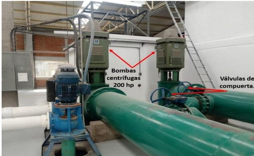
**Figura 4.7.** Sistema de bombeo del modelo del vertedor
