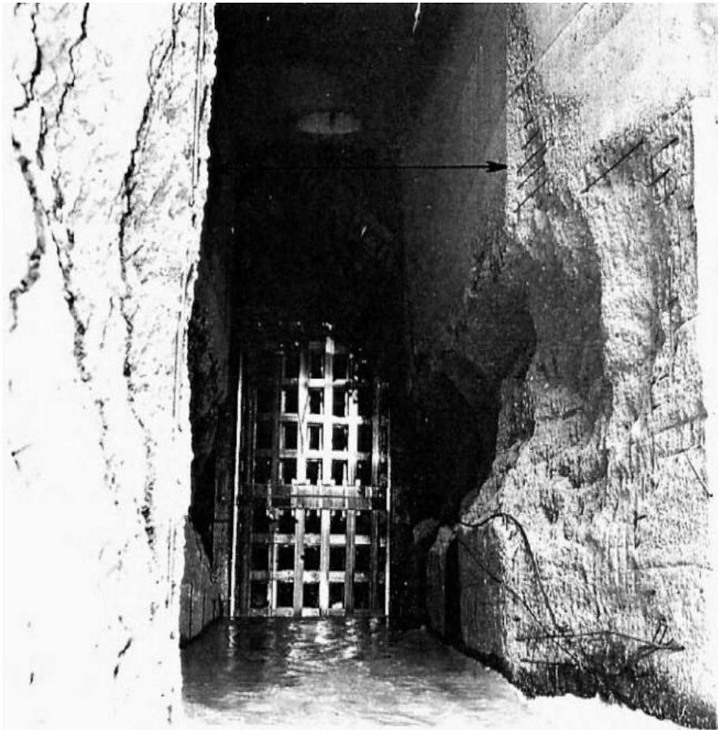
**Figura 3.11.** Daño por cavitación en uno de los vertedores de la presa Guri (Suárez Barrera,1997)
