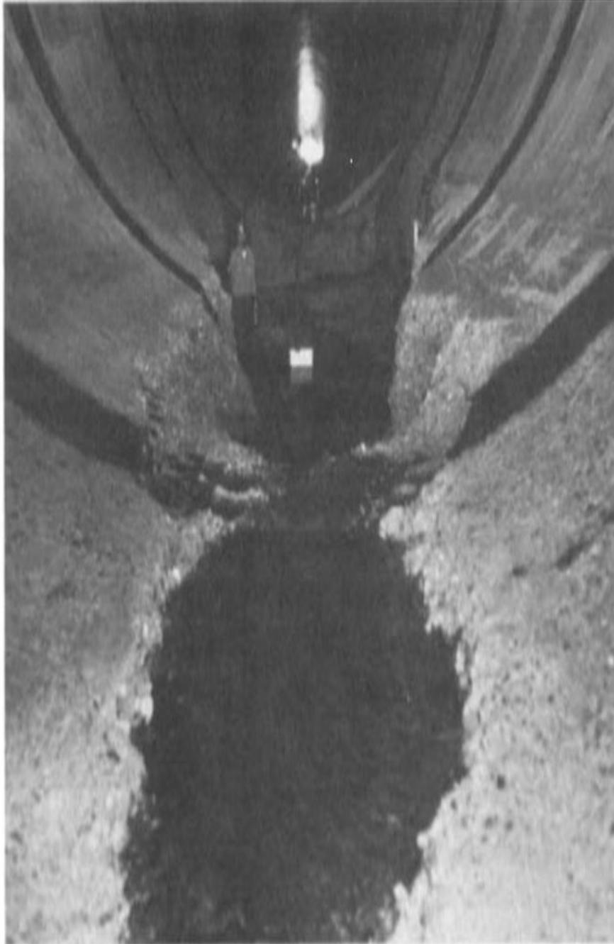
**Figura 3.12.** Daño por cavitación en el túnel del vertedor de la presa Yellowtail (Arndt, 2003)
