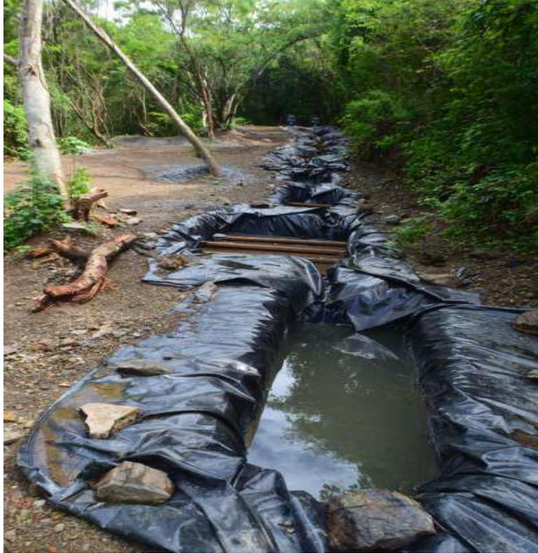
*Figura 6. Tratamiento pasivo in situ en Taxco, Guerrero. Sistema de piletas que funcionan como barreras geoquímicas al paso de DAM.*
