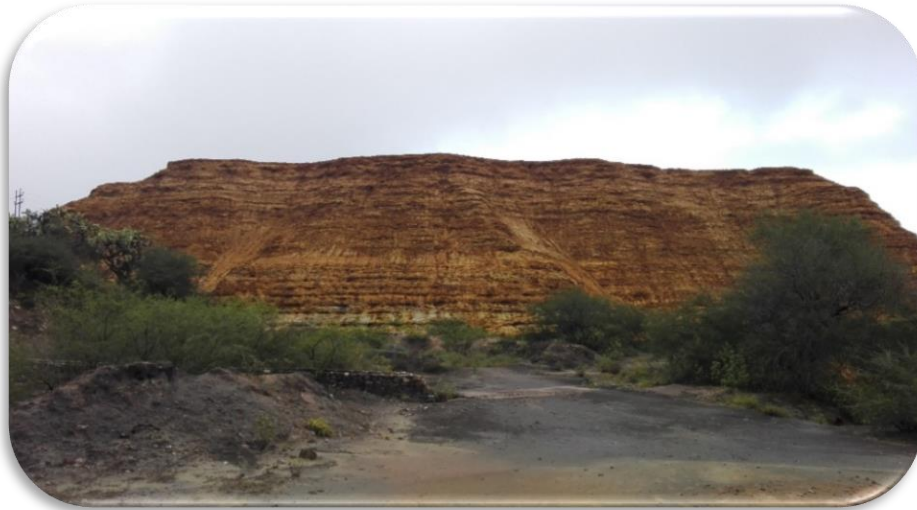
Figura 5. Vista frontal de la presa de jales Compañía Minera Zimapán (septiembre del 2016).
