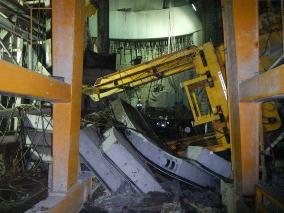
Figura 288. Caída de anillo durante su descenso a fondo de lumbrera.
