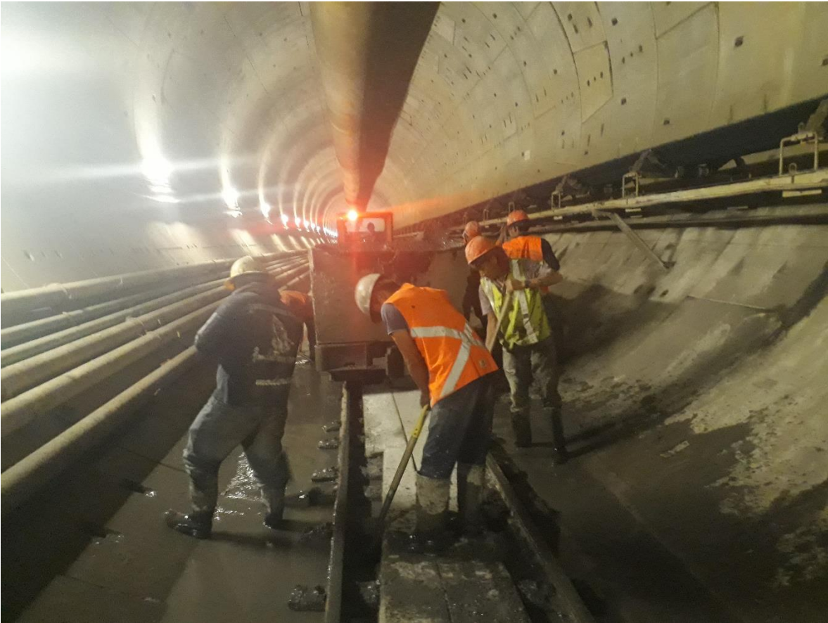
Figura 327. Labores de limpieza en túnel.
