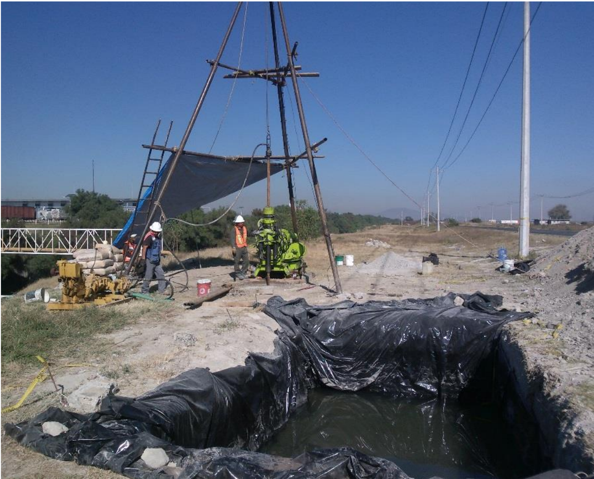
Figura 22. Sondeo exploratorio mediante la Prueba de Penetración Estándar (SPT).
