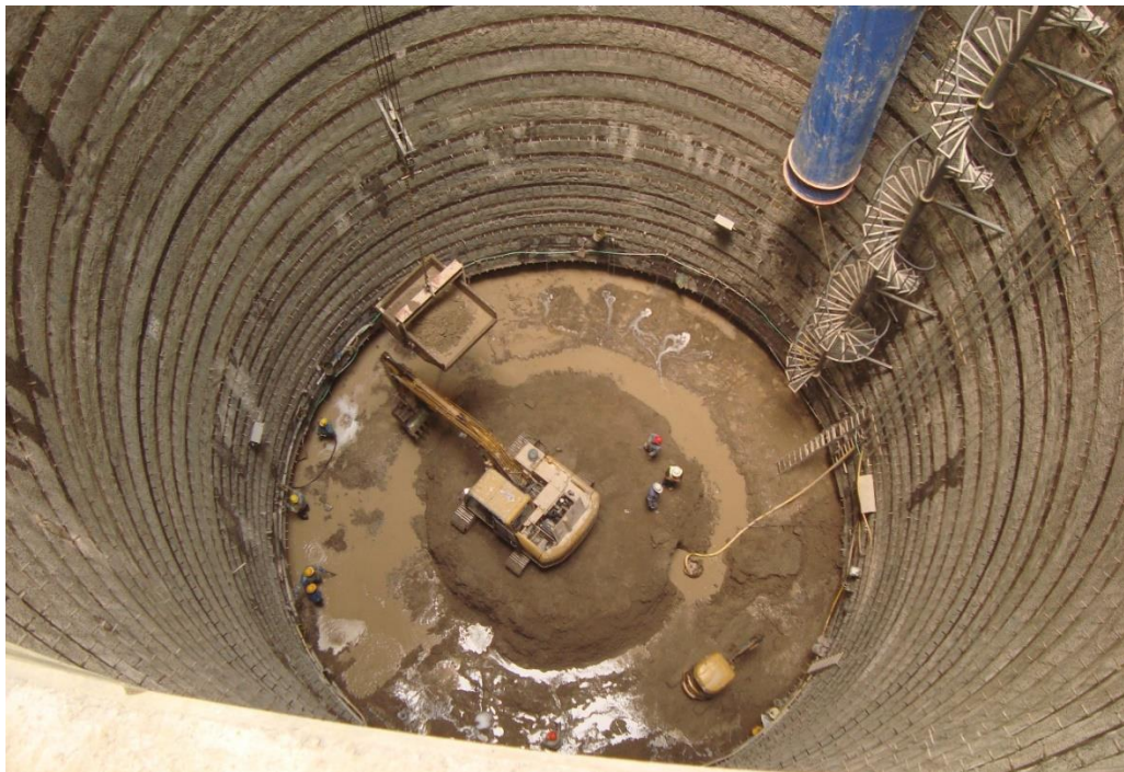
Figura 49. Excavación de núcleo central en su segunda etapa.
