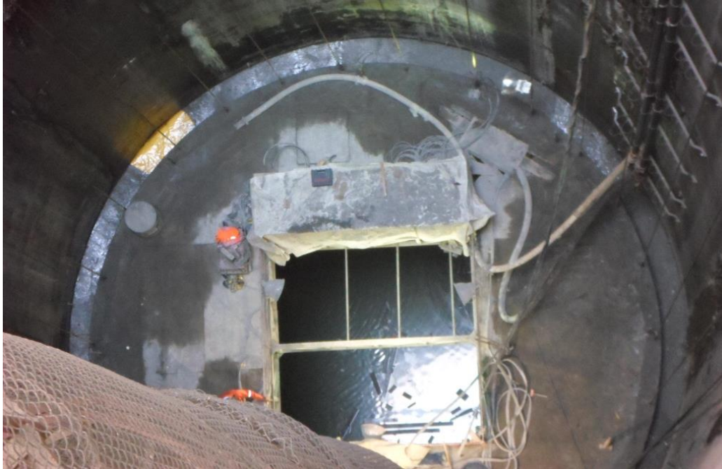
Figura 57. Cimbra deslizante para colado de muro secundario.
