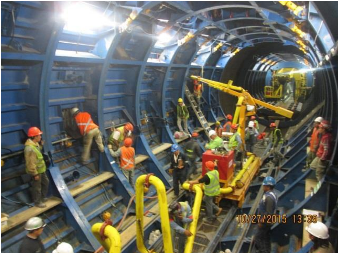
Figura 111. Snorkel retraible para inyección de concreto.
