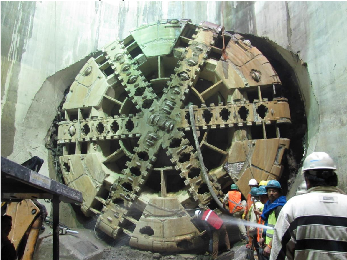
Figura 235. Rueda de corte a la salida de lumbreira L11.
