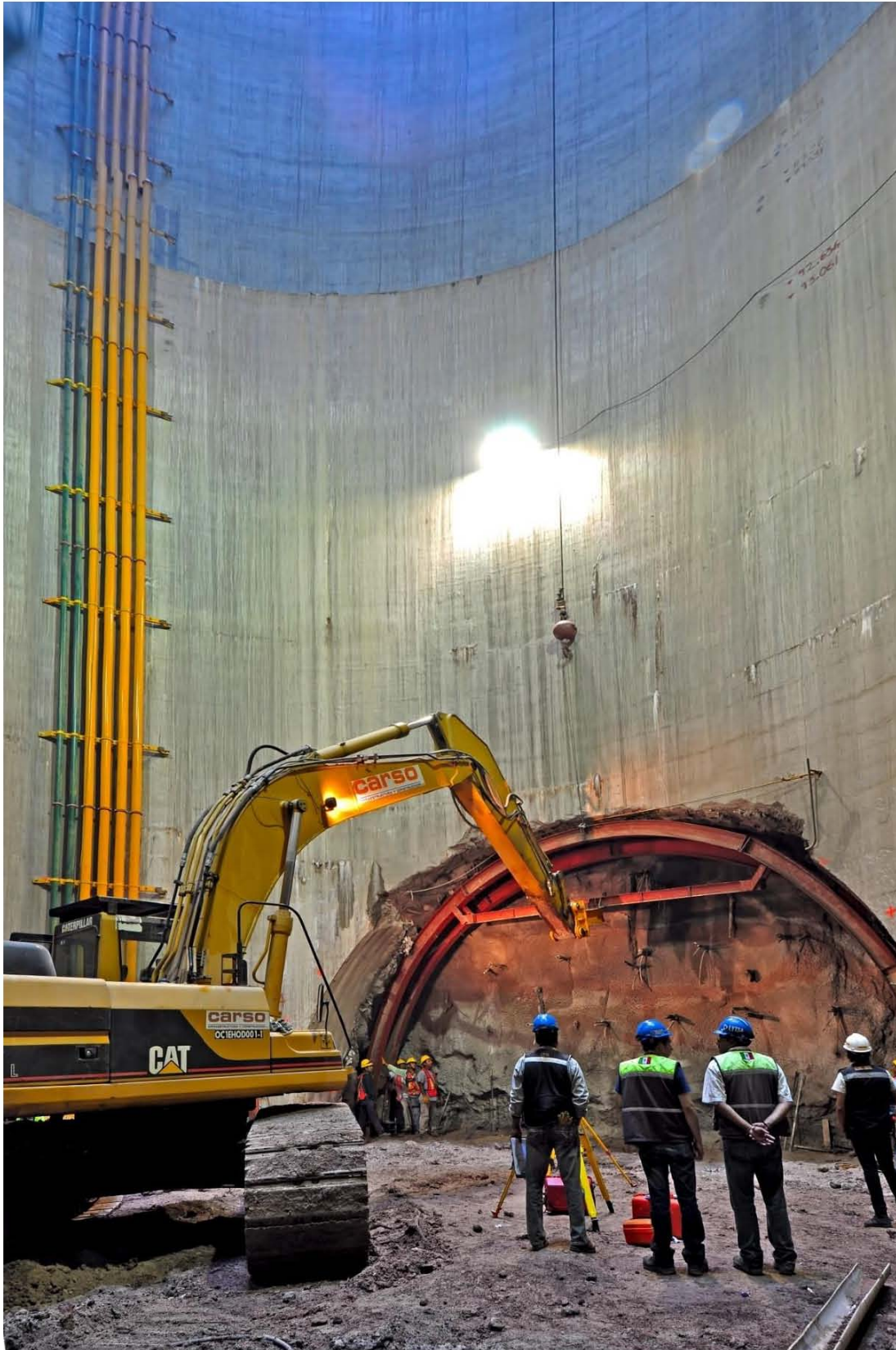
Figura 70. Colocación de los primeros marcos de la galería.
