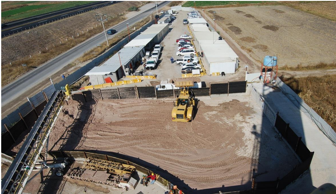
Figura 125. Dique de rezaga.
