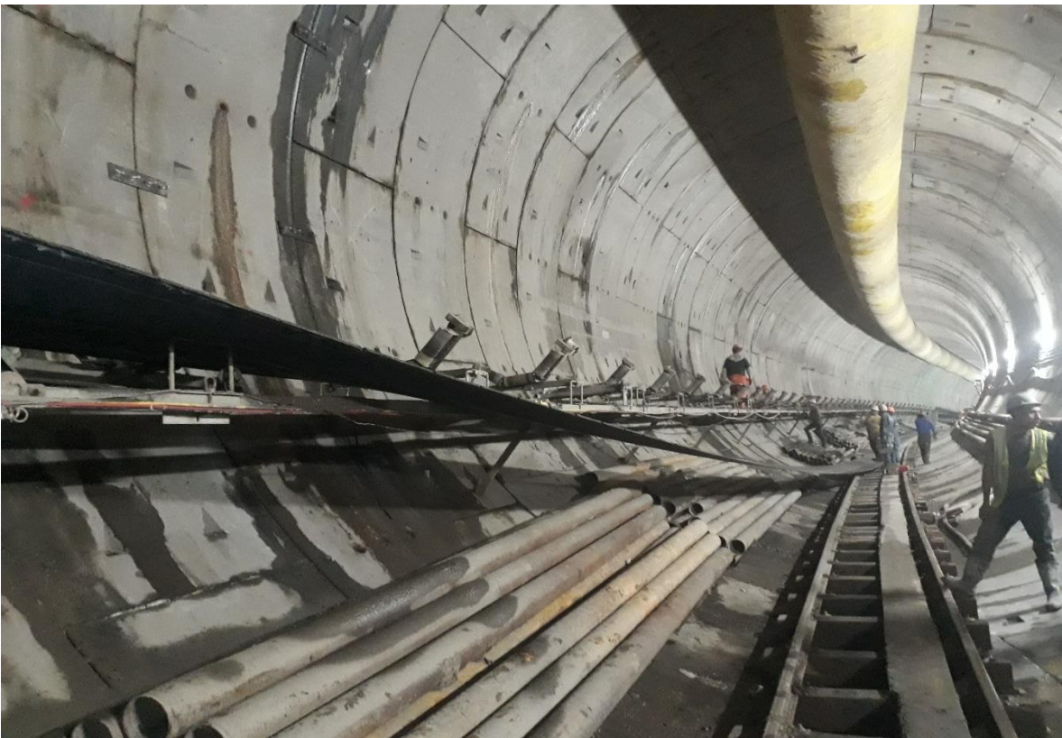
Figura 287. Desalineamiento de banda horizontal.
