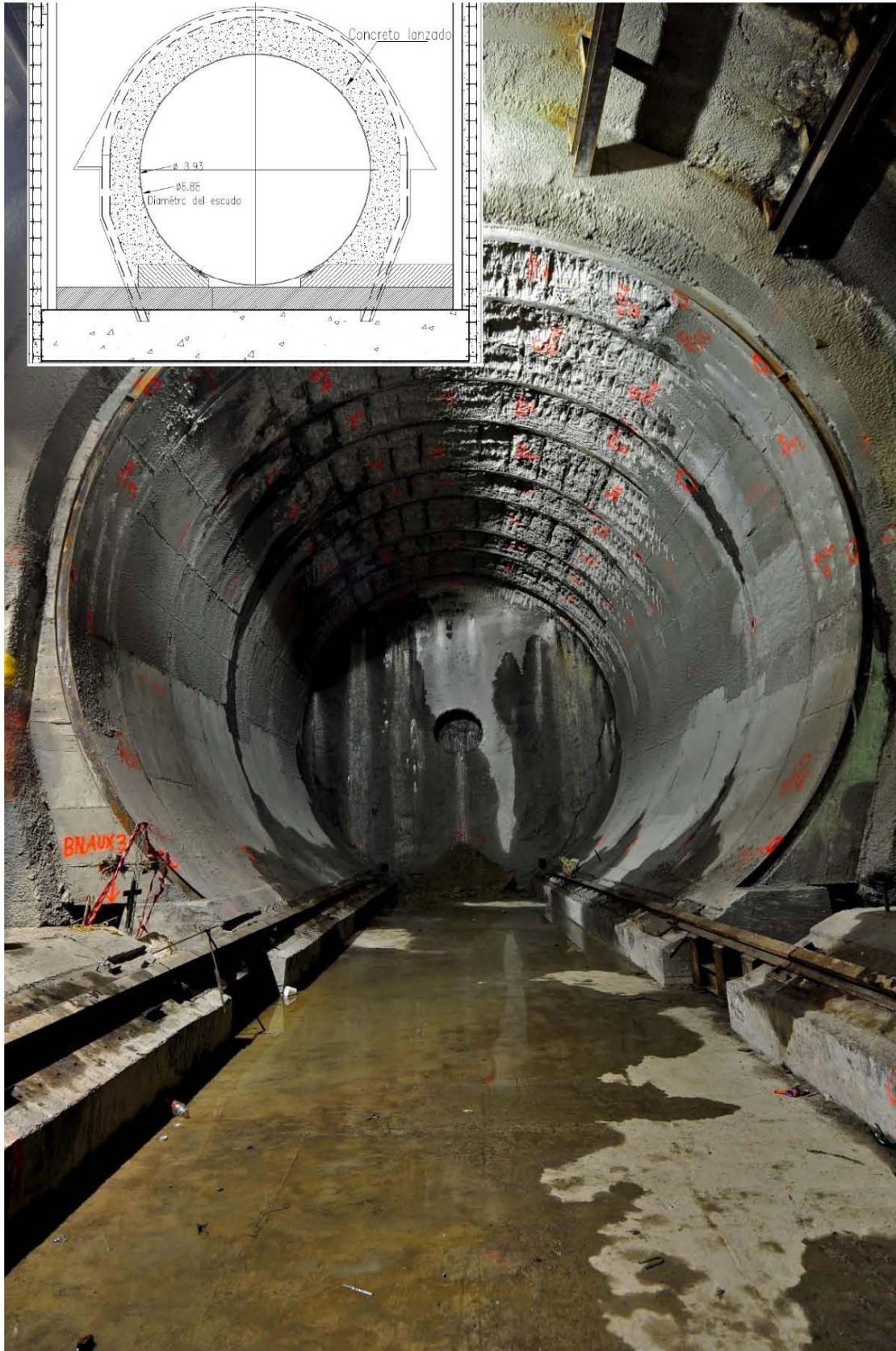
Figura 79. Segunda sección de la galería “rellenada” con concreto lanzado.
