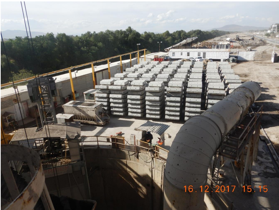
Figura 128. Patio de maniobras.
