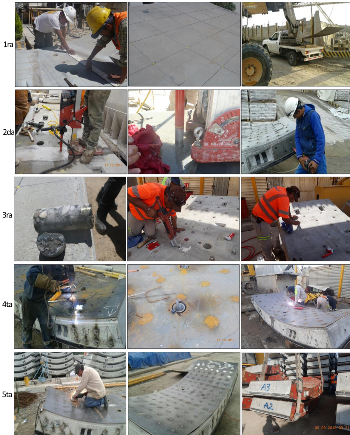
Figura 278. Proceso de recubrimiento metálico de dovelas.
