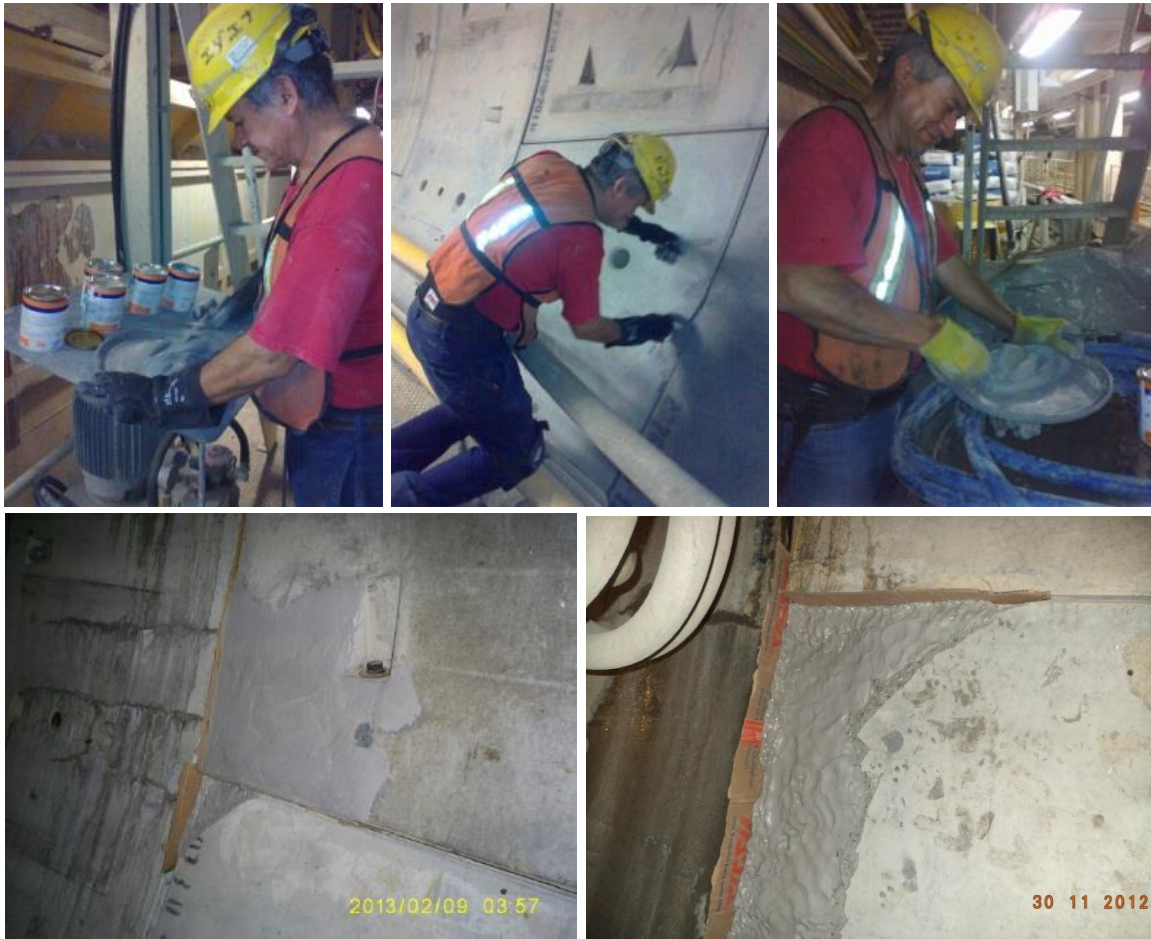
Figura 312. Resane de dovelas.
