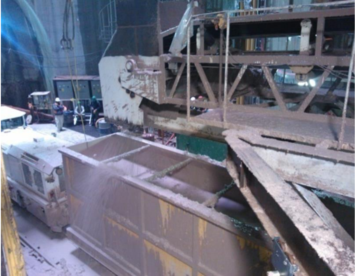
Figura 93. Bote de rezaga para extracción de material excavado.
