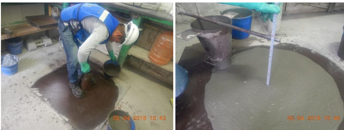
Figura 320. Prueba de revenimiento.
