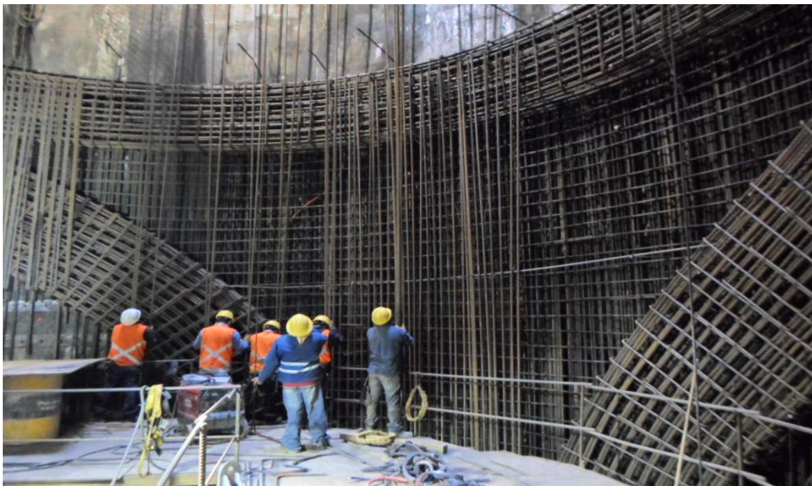
Figura 56. Habilitado de acero en muro y portales de la lumbrera.
