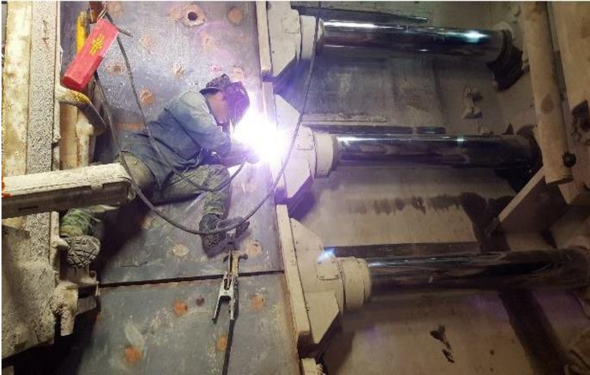
Figura 280. Aplicación de soldadura de unión con pads.
