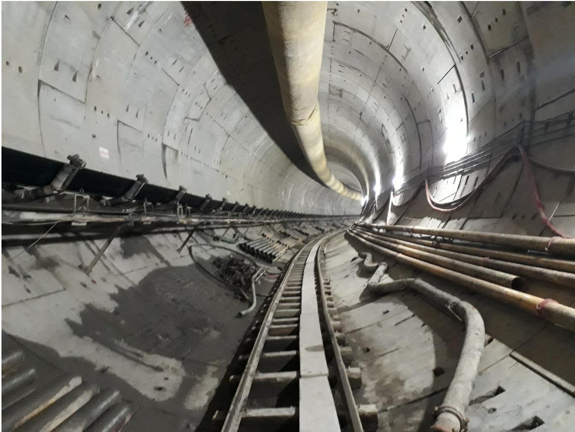
Figura 155. Instalaciones en túnel durante el proceso de excavación.
