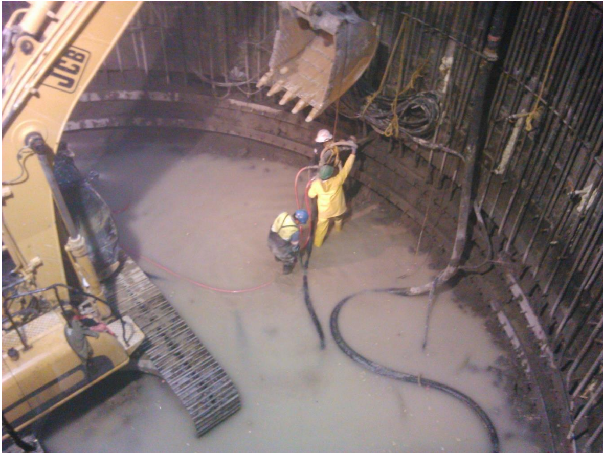
Figura 52. Concreto lanzado entre marcos metálicos.
