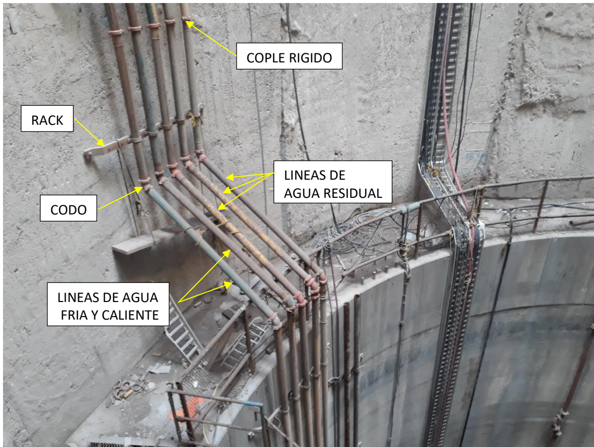
Figura 148. Instalación de tubería en pared de lumbraera.
