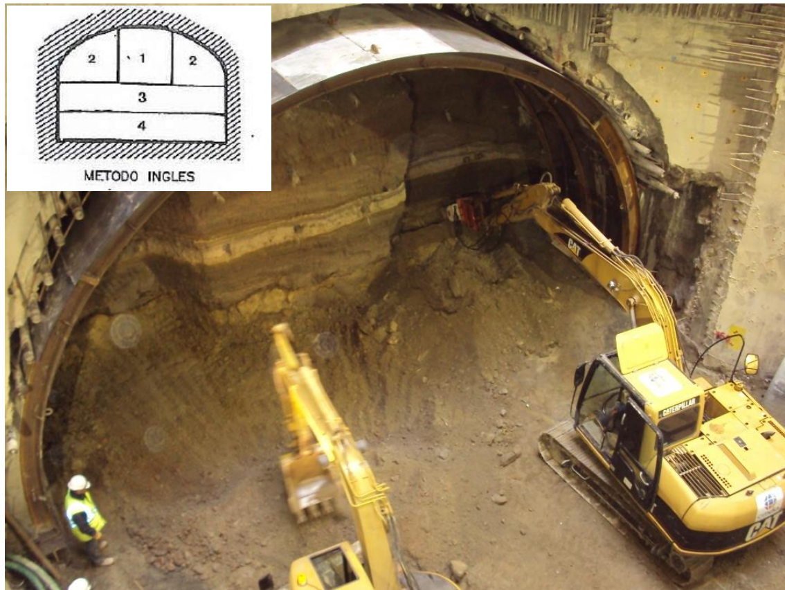
Figura 69. Secuencia de excavación de la galería.
