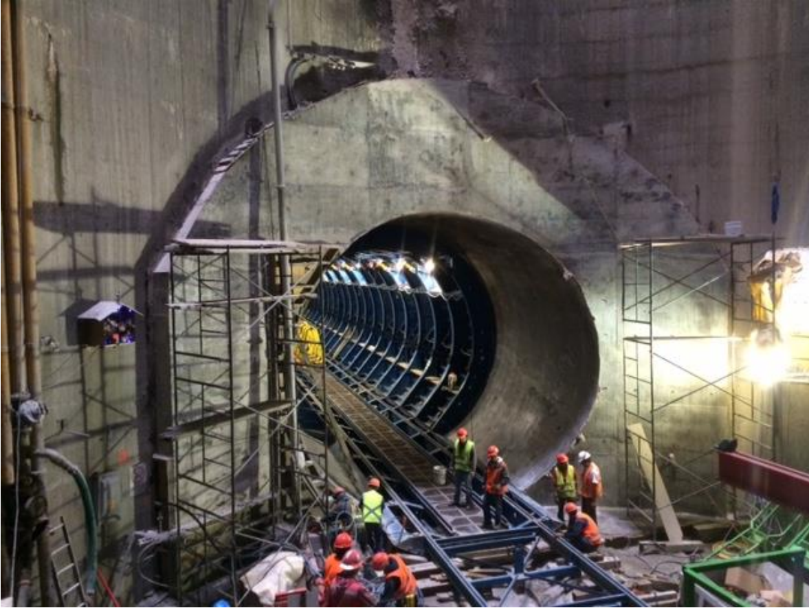
Figura 105. Emboquillado de portal de entrada a túnel.
