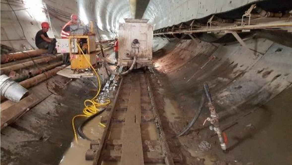
Figura 314. Reinyección en túnel.
