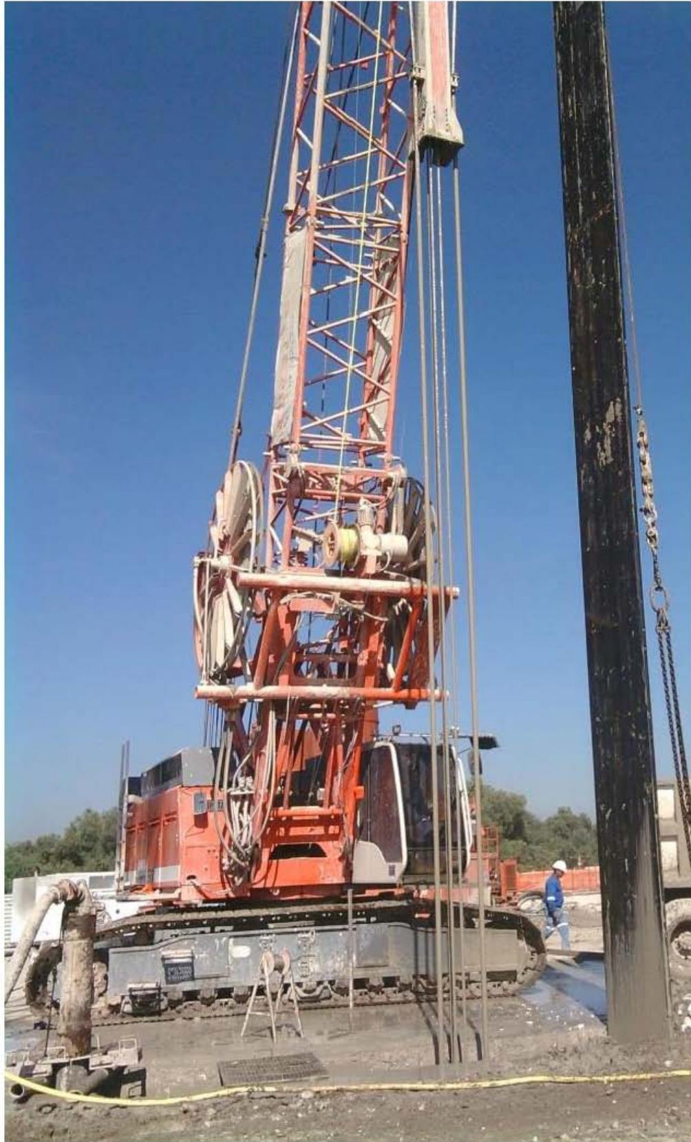
Figura 9. Hidrofresadora para excavación del muro Milán.
