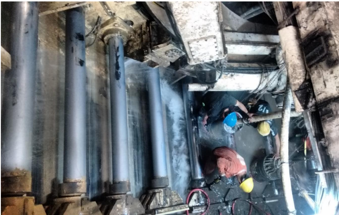
Figura 285. Salida de agua en zona de cepillos.
