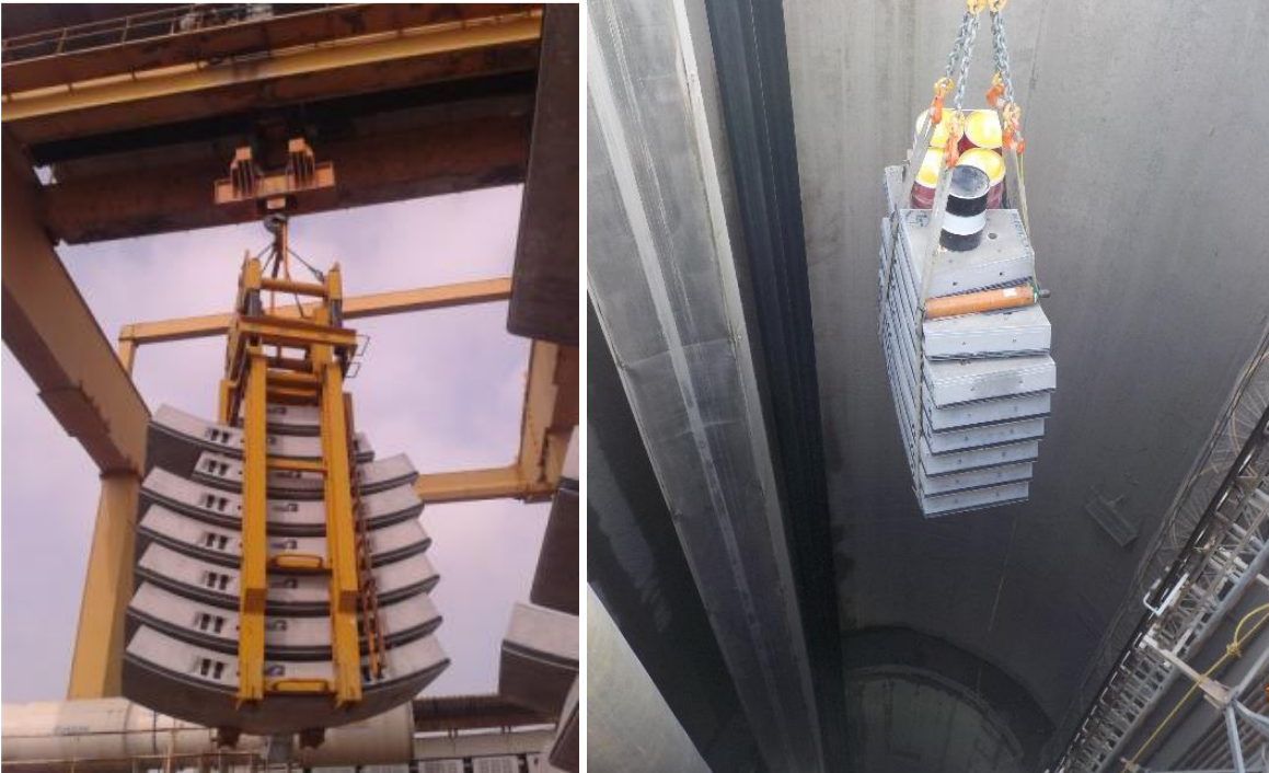
Figura 132. Descenso del anillo con pinza y con eslingas respectivamente.
