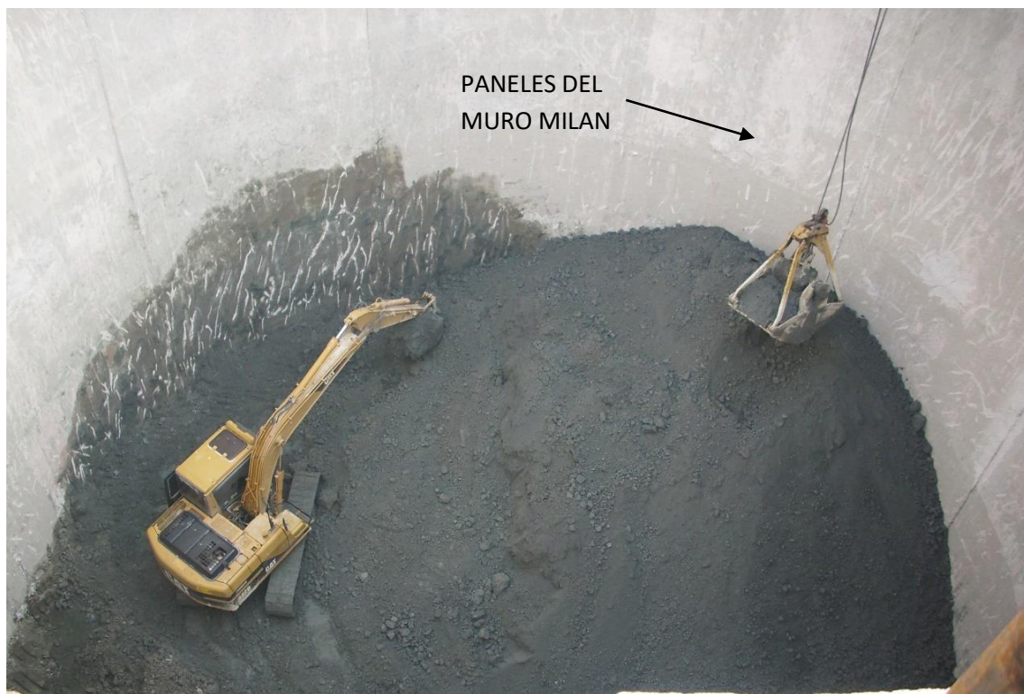
Figura 46. Excavación de núcleo central del muro Millán.
