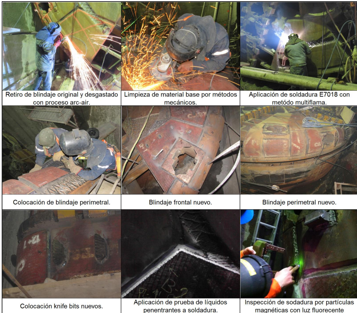
Figura 239. Proceso de reemplazo de blindaje de la rueda de corte.
