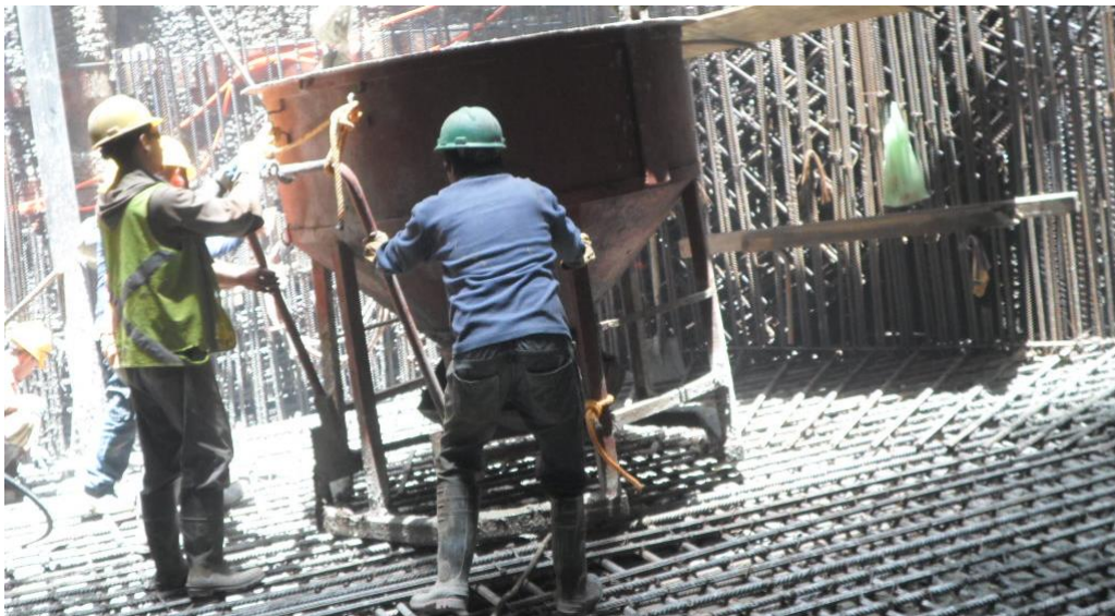
Figura 58. Bacha utilizada para colado de losa de fondo.
