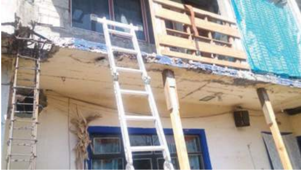
Imagen 20. Apuntalamiento de losa de la vivienda vecina.
