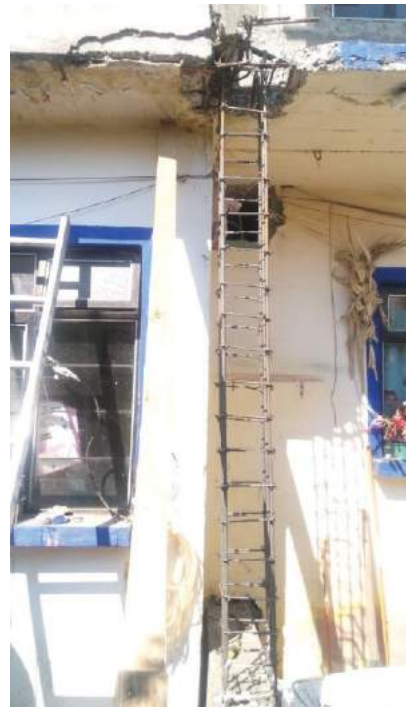
Imagen 19 Apuntalamiento de losa.
