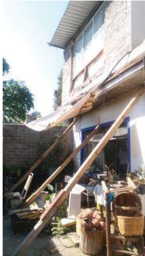
Imagen 24. Apuntalamiento de losa.
