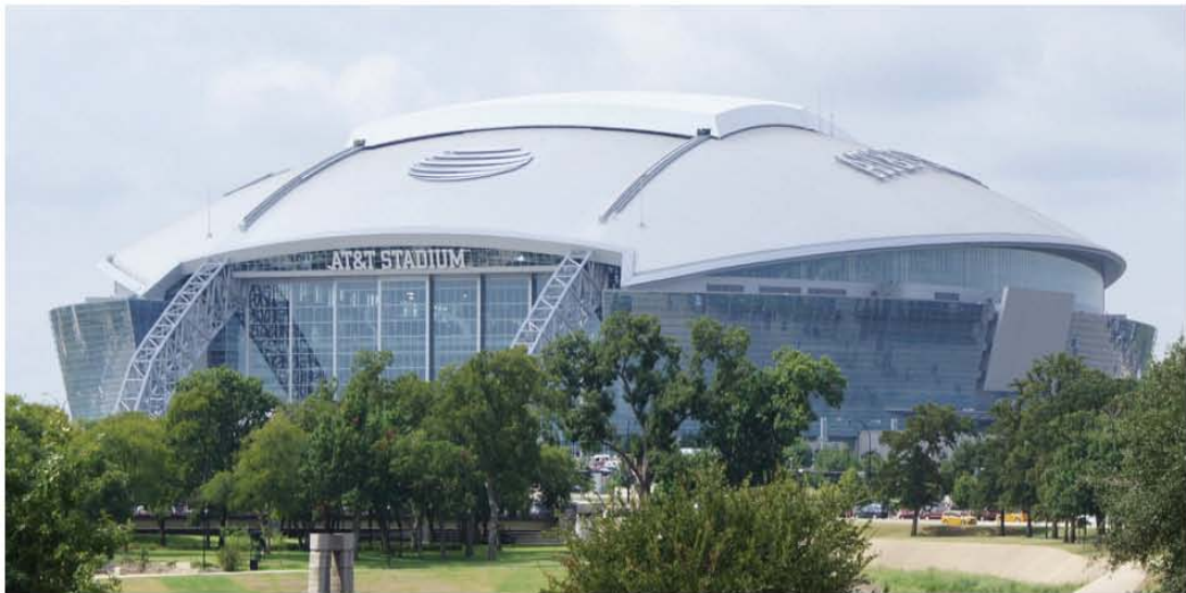
Figura 28. Estadio AT&T, antes estadio de los Vaqueros de Dallas. Texas, Arlington.
