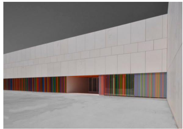
Fachada principal y acceso.
