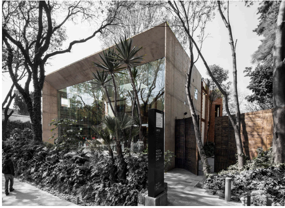
Fachada principal y acceso.
