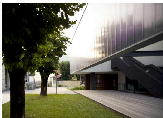
Fachada lateral acceso biblioteca.
