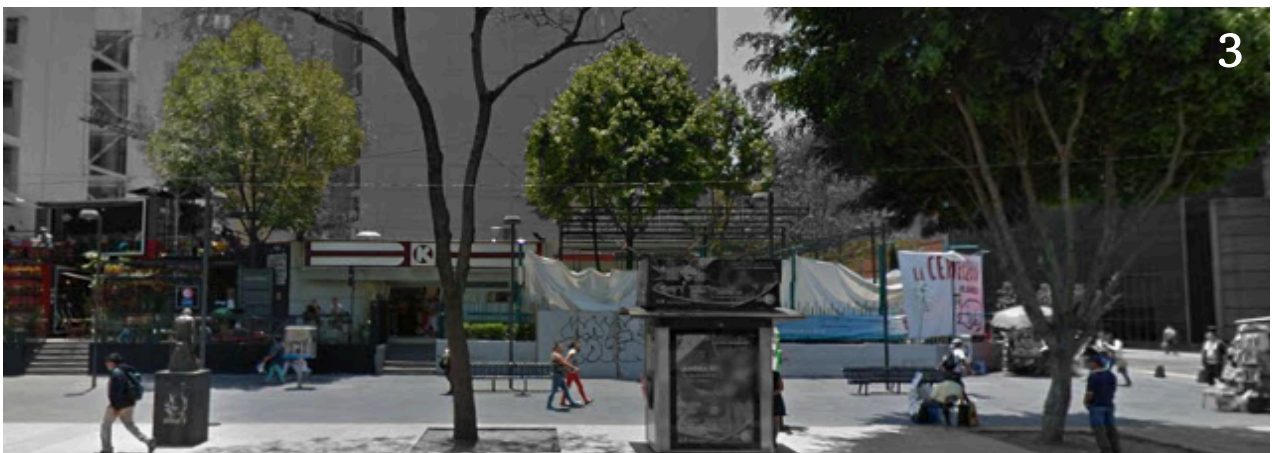
Fotografía de acceso y fachada principal a predio y proyecto.
