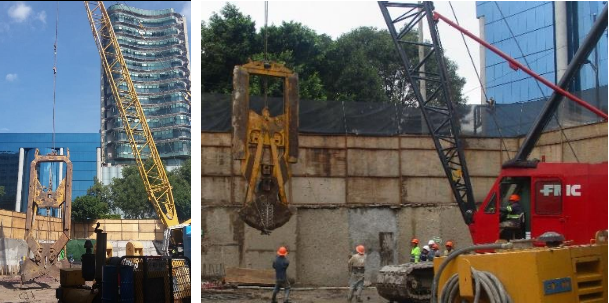
Foto 3. Equipo para la excavación.
