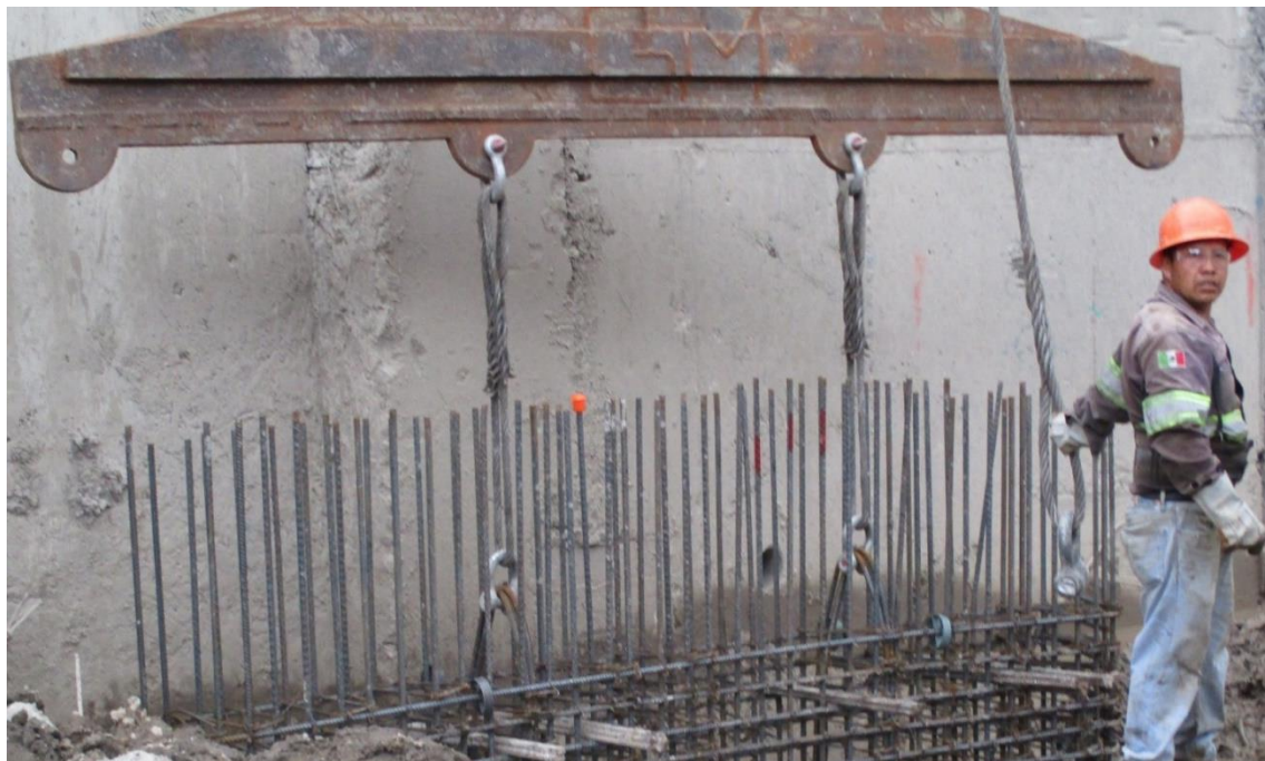
Foto 22. Retiro de balancín.
