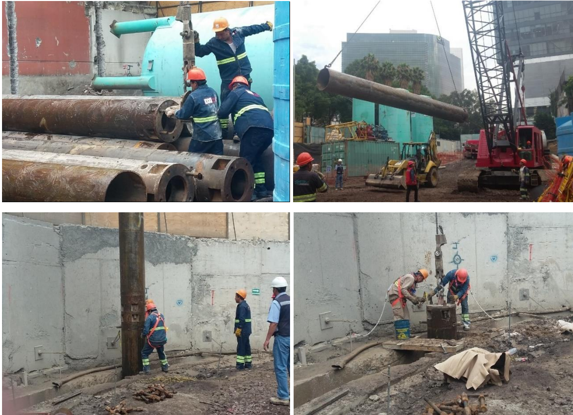
Foto 5. Juntas tubulares de sección circular entre tableros.
