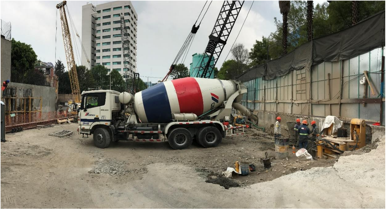
Foto 25. Vaciado de concreto.
