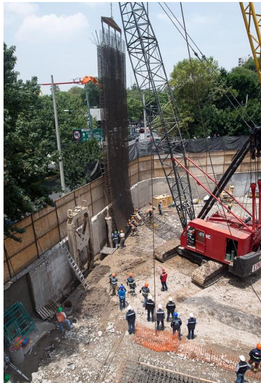
Foto 20. Colocación de armado en zanja.
