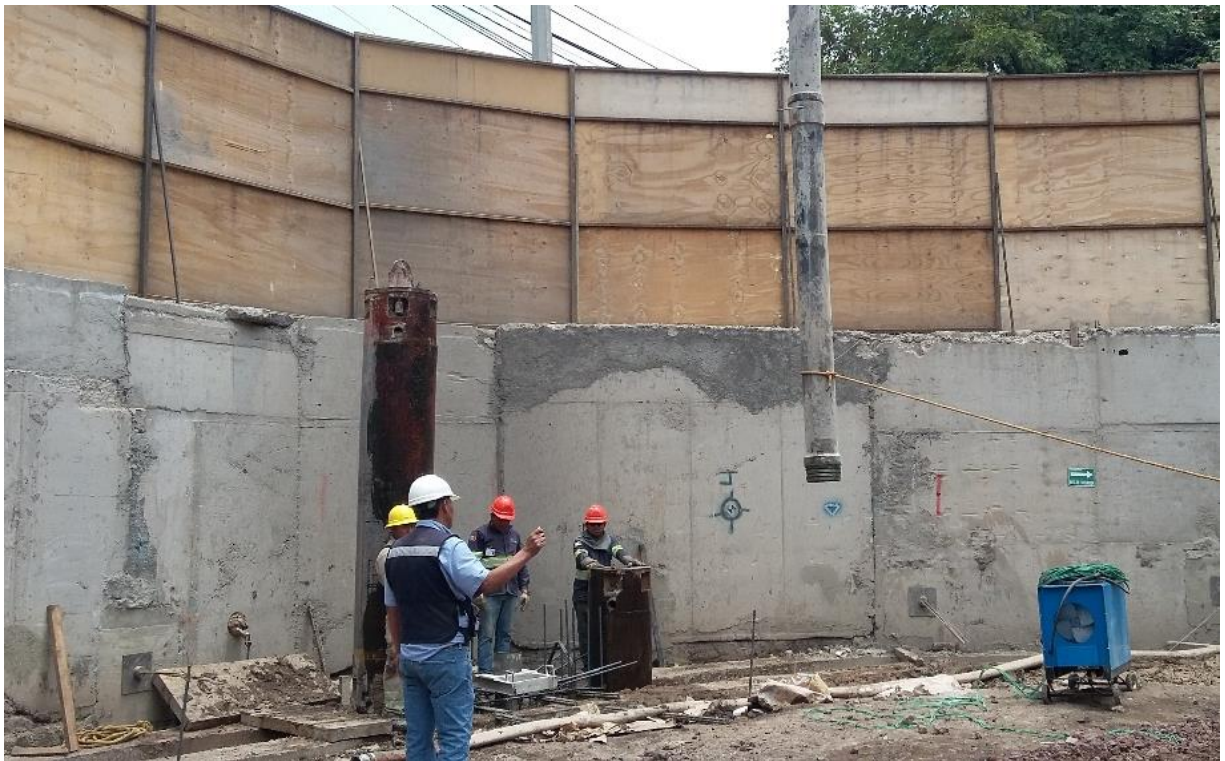
Foto 26. Retiro de junta.
