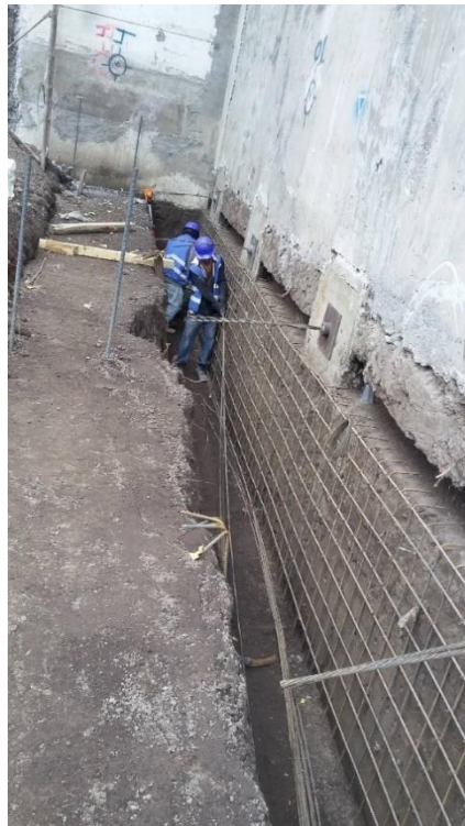
Foto 8. Armado de brocal.
