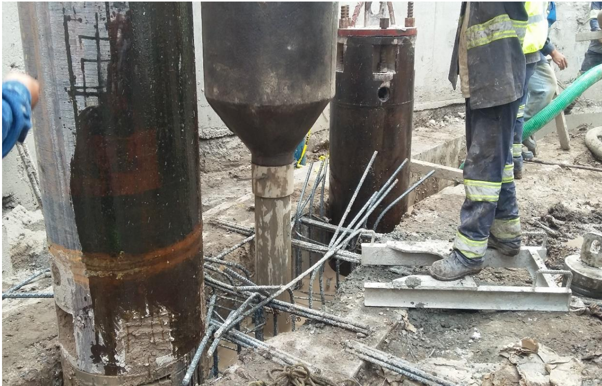
Foto 24. Colado con tubería Tremie.
