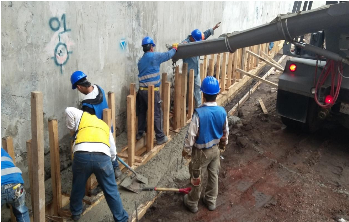
Foto 10. Colado de brocal.
