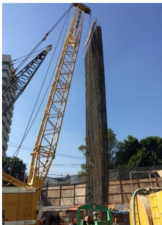
Foto 18. Izado de armado de acero.
