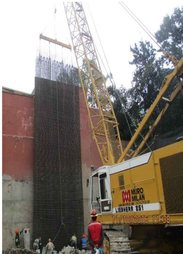
Foto 21. Descenso de armado en zanja.
