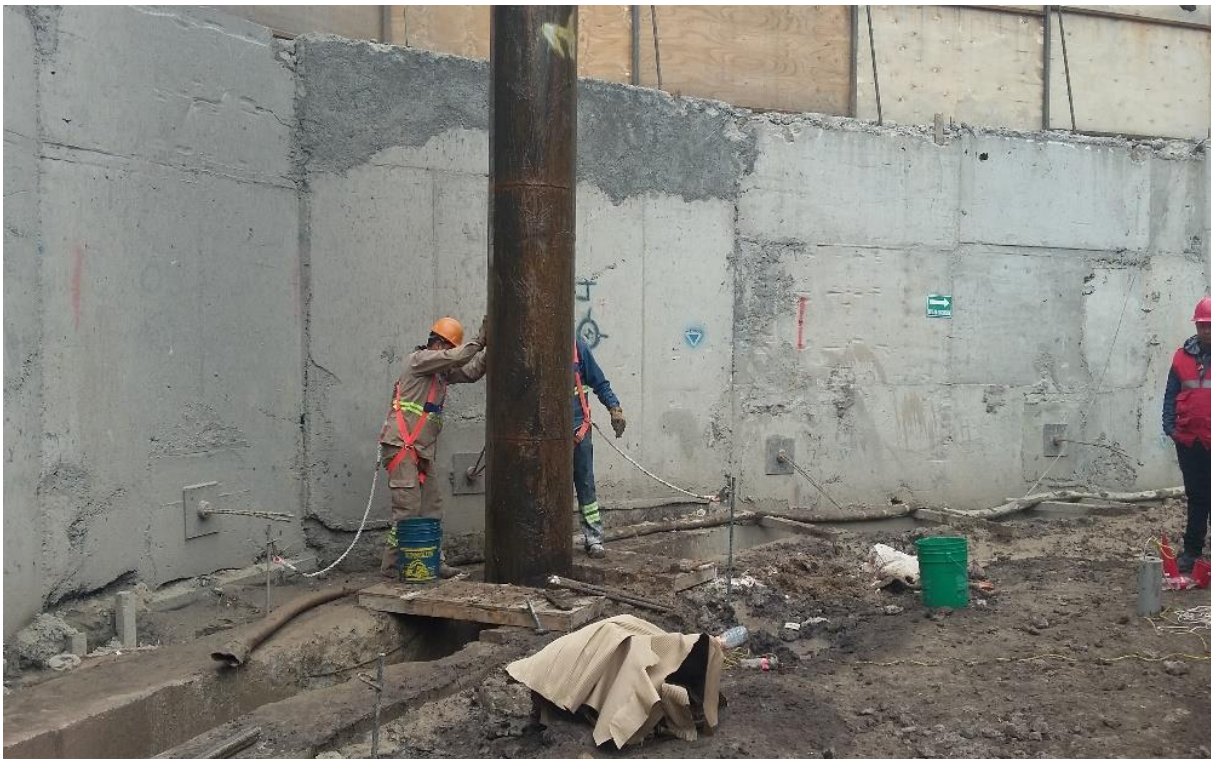
Foto 16. Colocación de junta en zanja.
