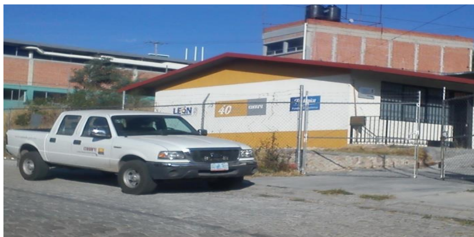
Fotografía 1. Exterior de las instalaciones de la sede León
