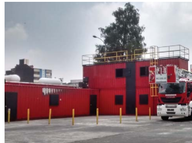
Ilustración 40. Casa de humo en la Estación Central de bombeos de la CDMX. Fotografía personal
