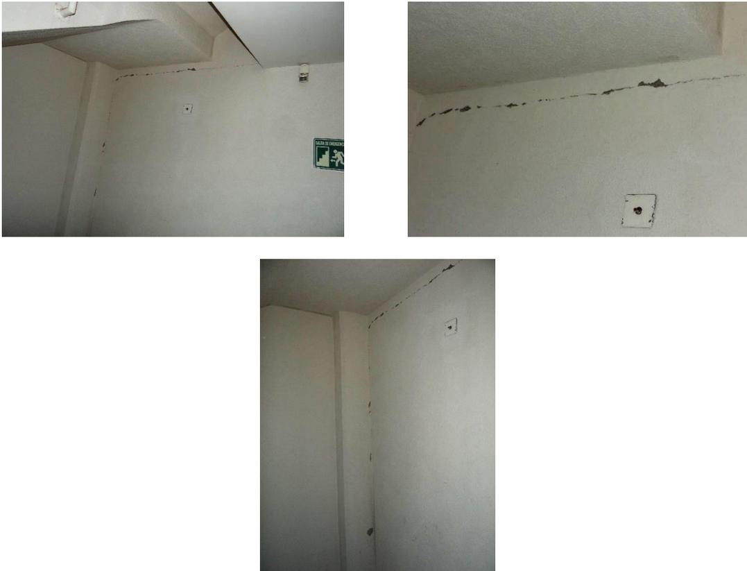
*Fig. 4.22 Grietas de separación del muro de mampostería con elementos estructurales en el cubo de escaleras del nivel N4 tras el sismo SI-131 (Ochoa, 2015).*
