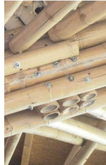
En estas imágenes<sup>28</sup> observamos la unión entre vigas con varilla roscada que atraviesa de lado a lado las vigas y las cuales se fijan con pernos y rondanas
