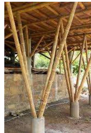
FOTO 2, ESTRUCTURA DE BAMBÚ APOYADA EN SOBRECIMENTOS – 05/2019
