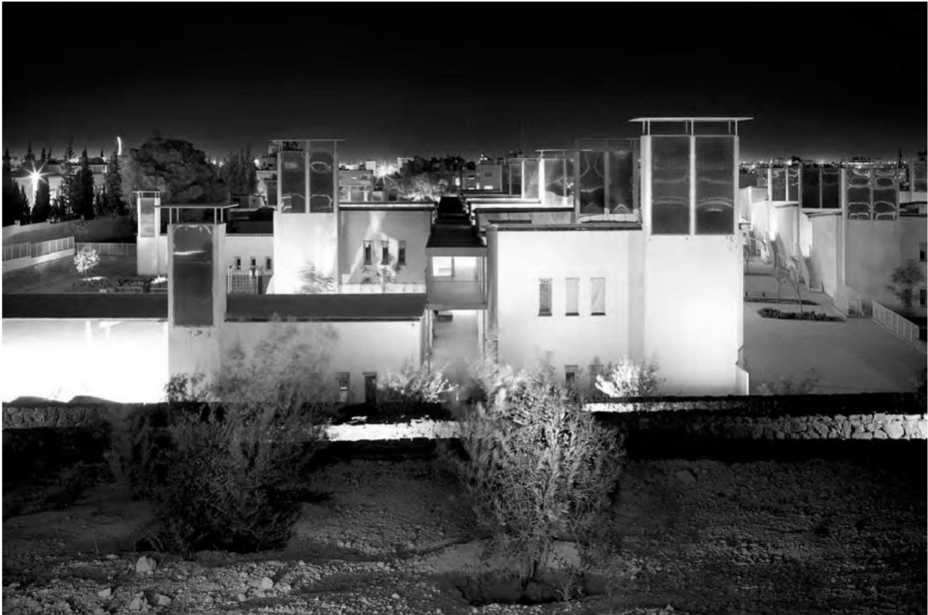
Figura 2.15 Chimeneas solares en el colegio Lycée français Charles de Gaulle, ubicado en Damasco (Samhuri, 2013)
