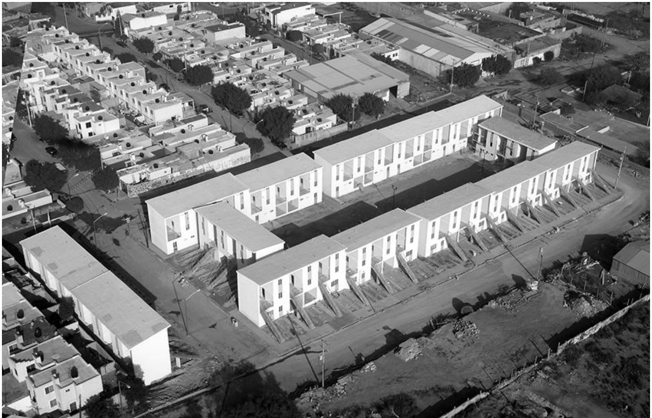
Figura 4.1 Proyecto Monterrey. (Elemental, 2018)
