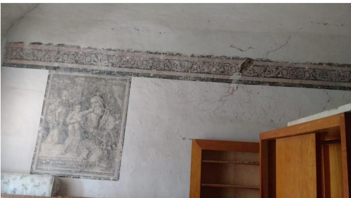
Imagen 323. Fisuras en muro y desprendimiento de enlucido, 2017. Foto. Laura Moyers Ruíz.
