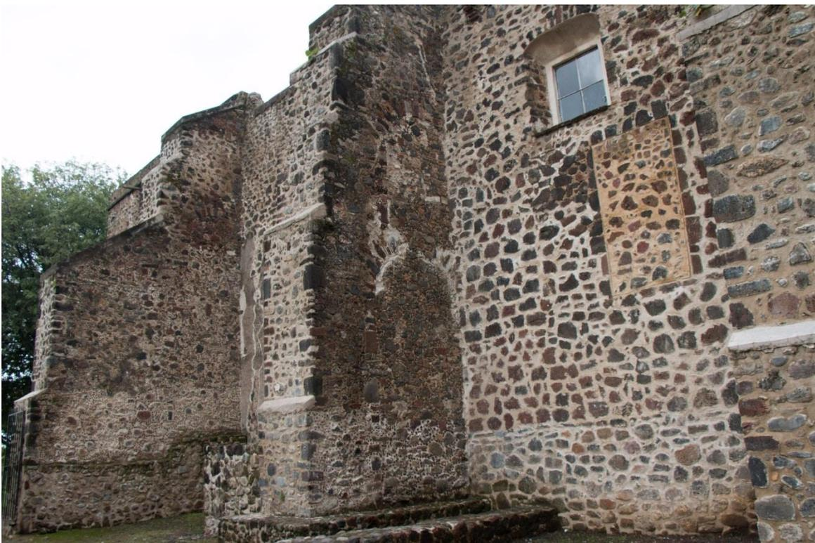
Imagen 269. Descubrimientos entre el primero y segundo contrafuertes del muro norte, 2014, San Guillermo, Totolapan, Mor., Foto. J. Vicente Torres León.
