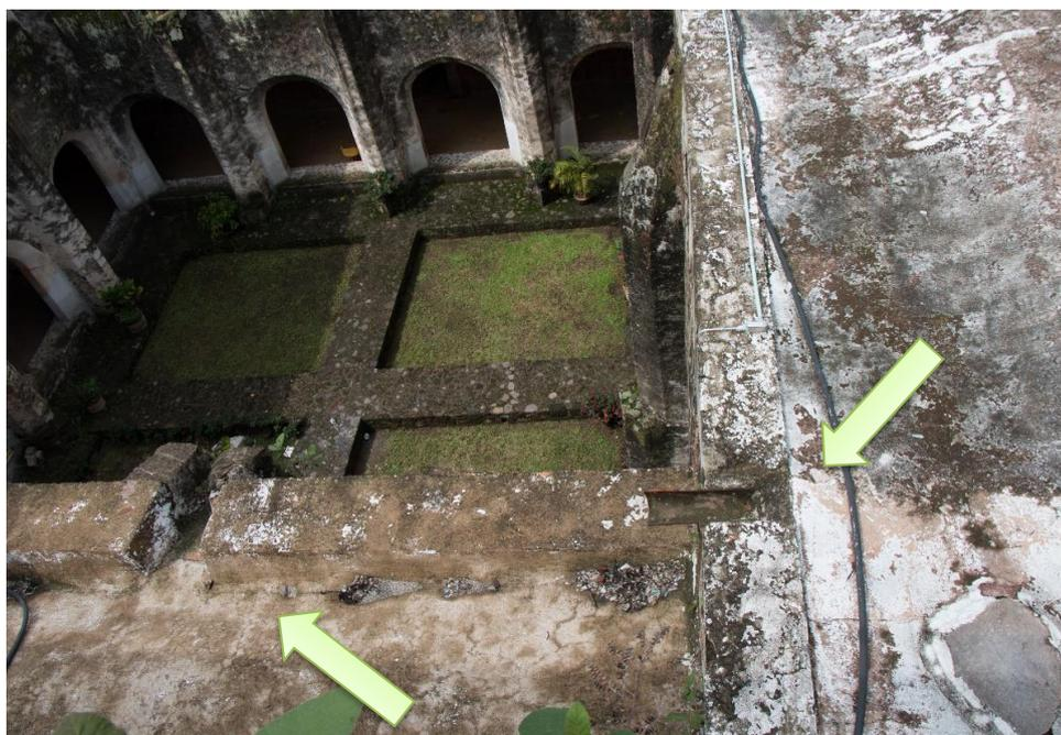
Imagen 132. Bajadas de agua pluvial, San Guillermo, Totolapan, Mor. 2014.
