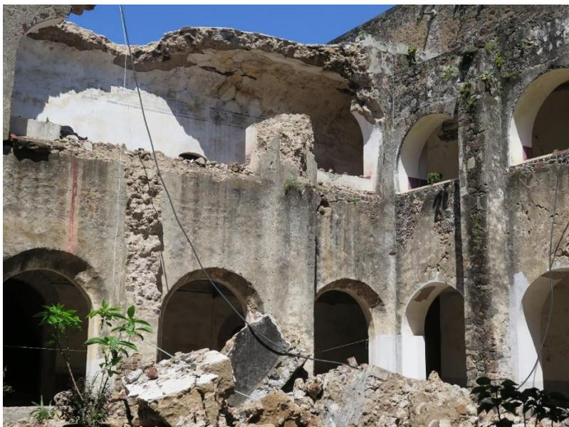
Imagen 295. Derrumbe pilares-muretes y bóveda en el pasillo poniente del claustro alto, 2017. Foto. Martha Fernández.
