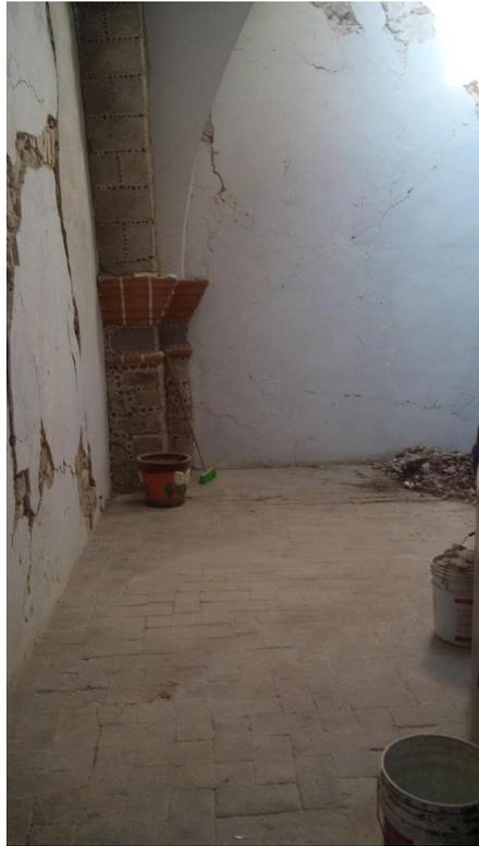
Imagen 293. Cuarteaduras y desprendimiento de enlucidos en los muros del coro, 2017.
