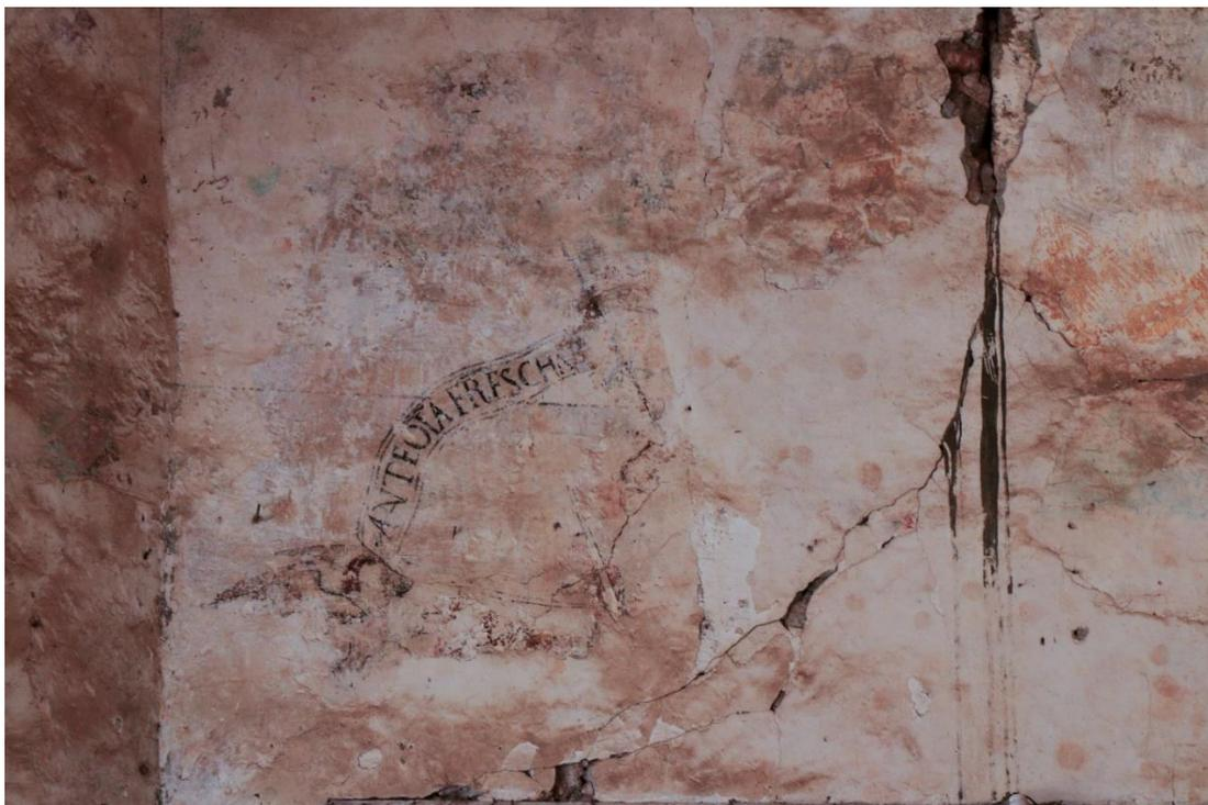
Imagen 308. Fisuras y fractura en el muro norte de la portería, 2014.
