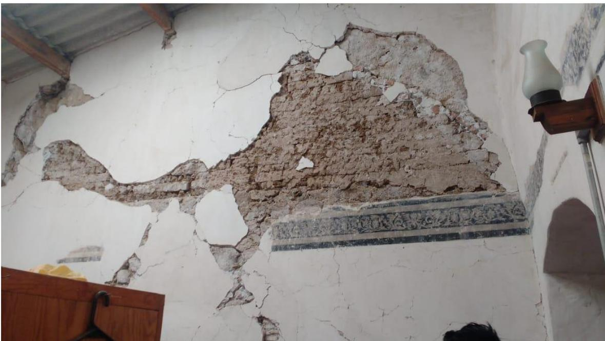
Imagen 322. Fracturas y desprendimiento de aplanado en muro de dormitorio, 2017.
