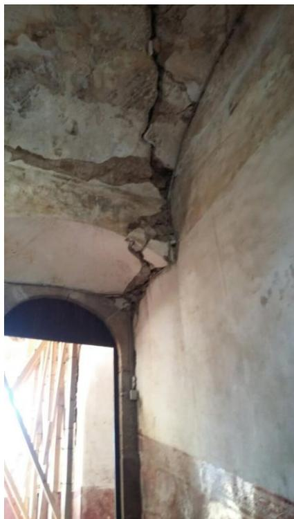
Imagen 338. Fracturas en la bóveda, acceso al claustro alto, cubo de escaleras, 2018.
