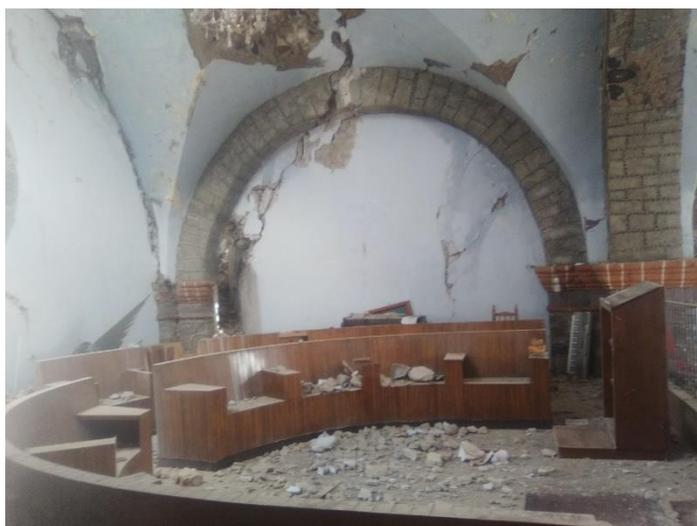
Imagen 292. Fracturas y agrietamientos en el muro norte del coro, 2017.
