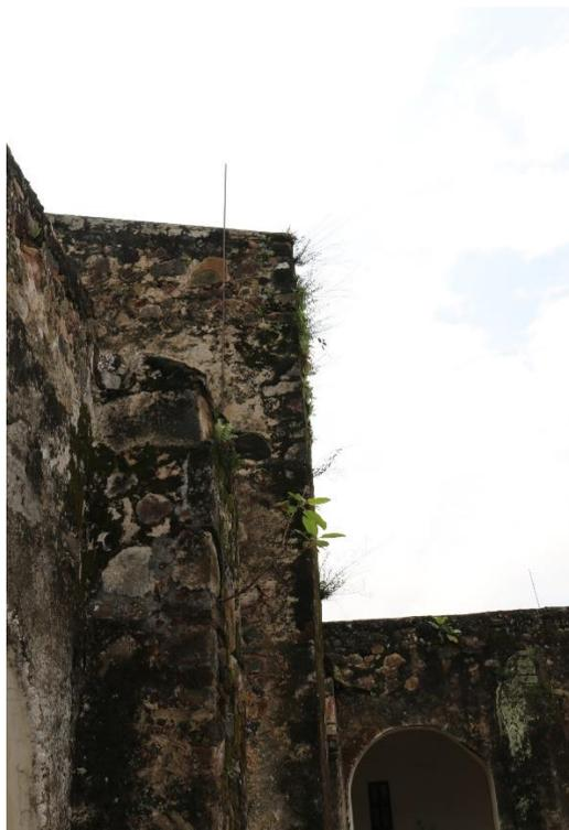
Imagen 301. Plantas y hierbas en los contrafuertes del patio del claustro, contrafuerte del muro norte, 2014. Foto. Laura Moyers Ruiz.
