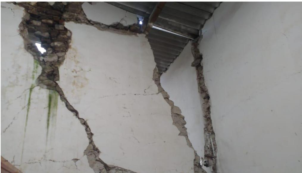
Imagen 319. Fractura en muro de dormitorio, bajo lámina acanalada, 2017.
