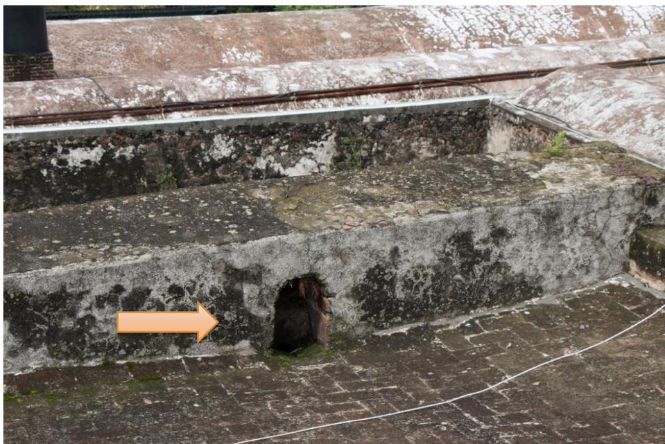
Imagen 131. Bajada de agua pluvial, San Guillermo, Totolapan, Mor. 2014.
