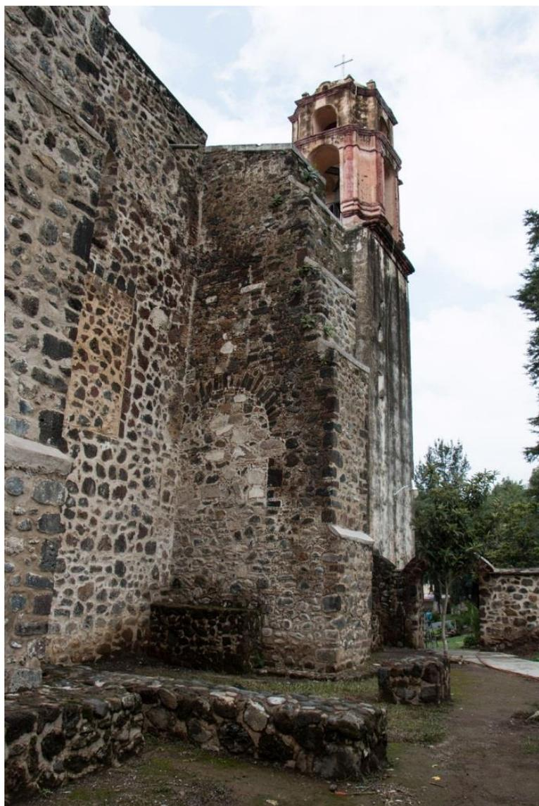
Imagen 98. Contrafuerte o estribo con arco ciego de descarga, en muro norte del templo, San Guillermo, Totolapan, Morelos, 2014. Foto. J. Vicente Torres León.
