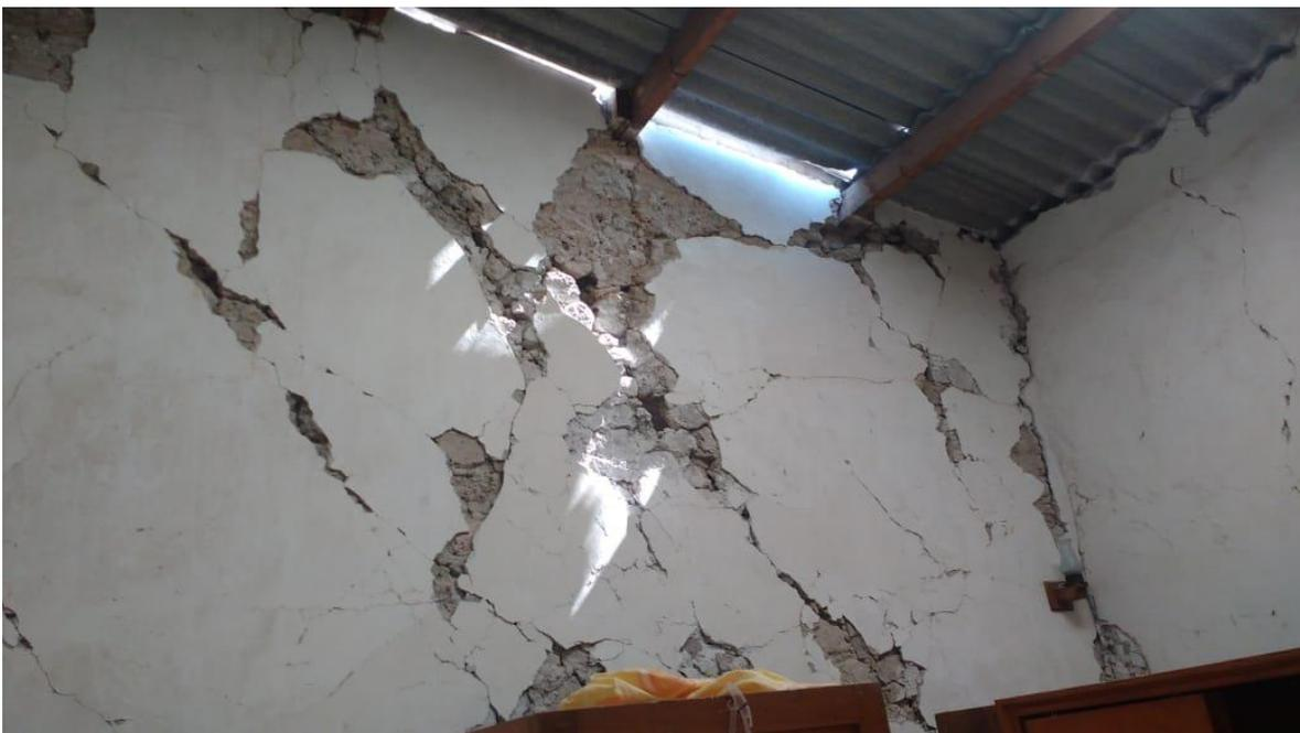
Imagen 320. Fracturas, grietas y desprendimiento de aplanado en muro de dormitorio, 2017. Foto. Laura Moyers Ruíz.
