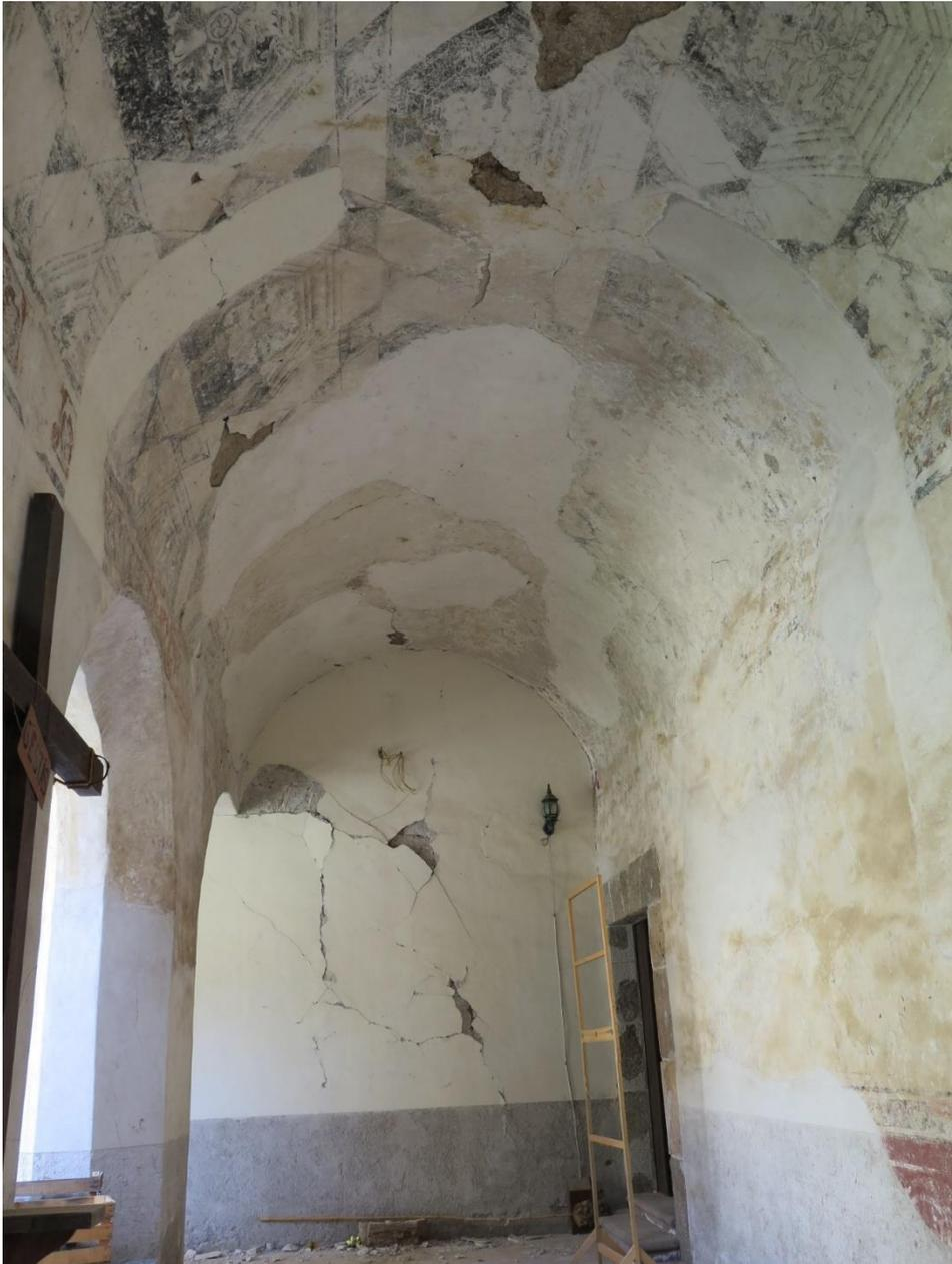
Imagen 297. Desprendimiento en el muro sur del templo, así como de la bóveda del pasillo oriente del claustro bajo, 2017. Foto. Martha Fernández.
