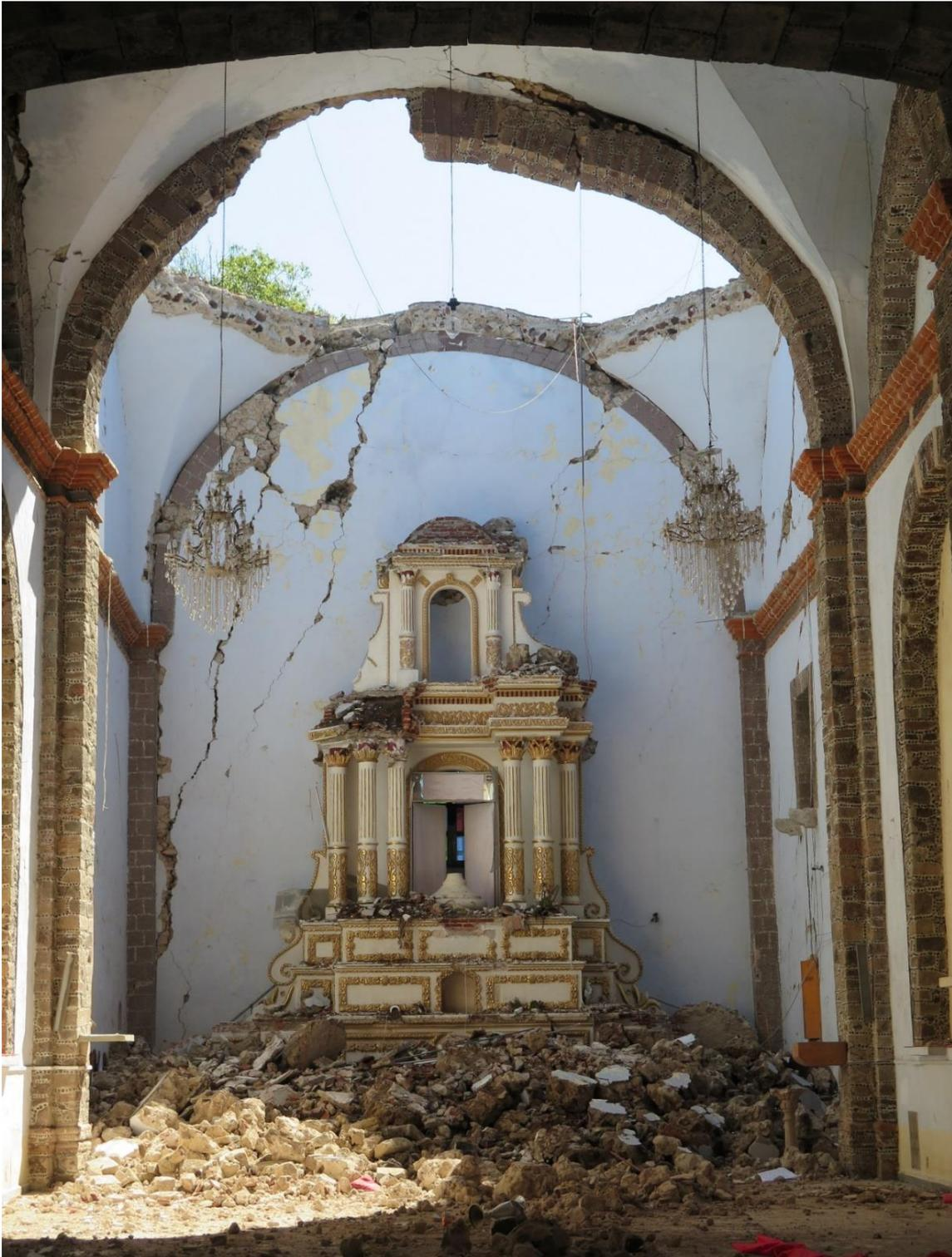
Imagen 287. Ábside y retablo, pérdida total de la cúpula y fracturas en los muros del presbiterio, 2017. Foto. Martha Fernández.
