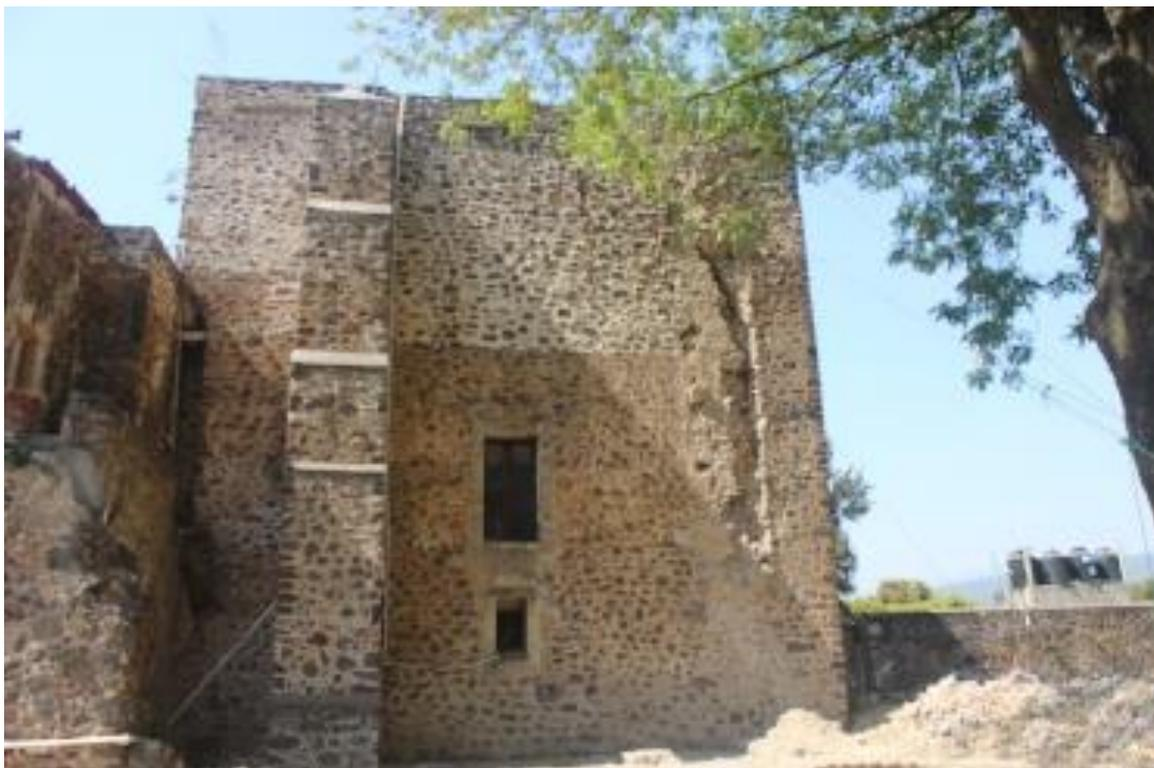
Imagen 344. Derrumbe del contrafuerte de la esquina de la fachada oriente del templo, San Guillermo, Totolapan, Mor., 2018. Foto. Laura Moyers Ruíz.
