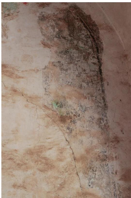
Imagen 309. Fisura en el muro sur de la portería, 2014. Foto. Laura Moyers Ruiz.
