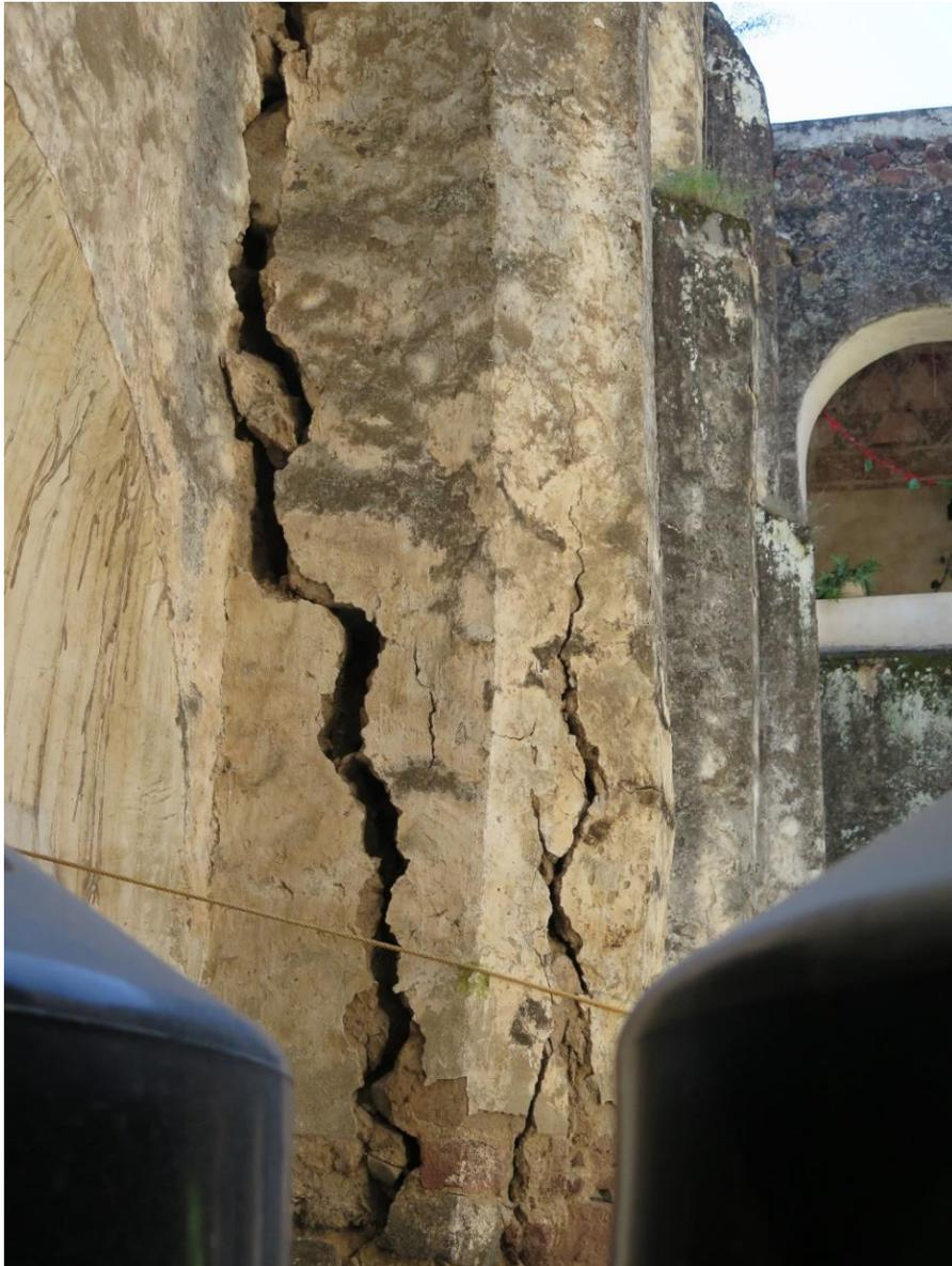
Imagen 299. Grietas y fracturas en el contrafuerte del muro oriente del claustro bajo, 2017. Foto. Martha Fernández.
