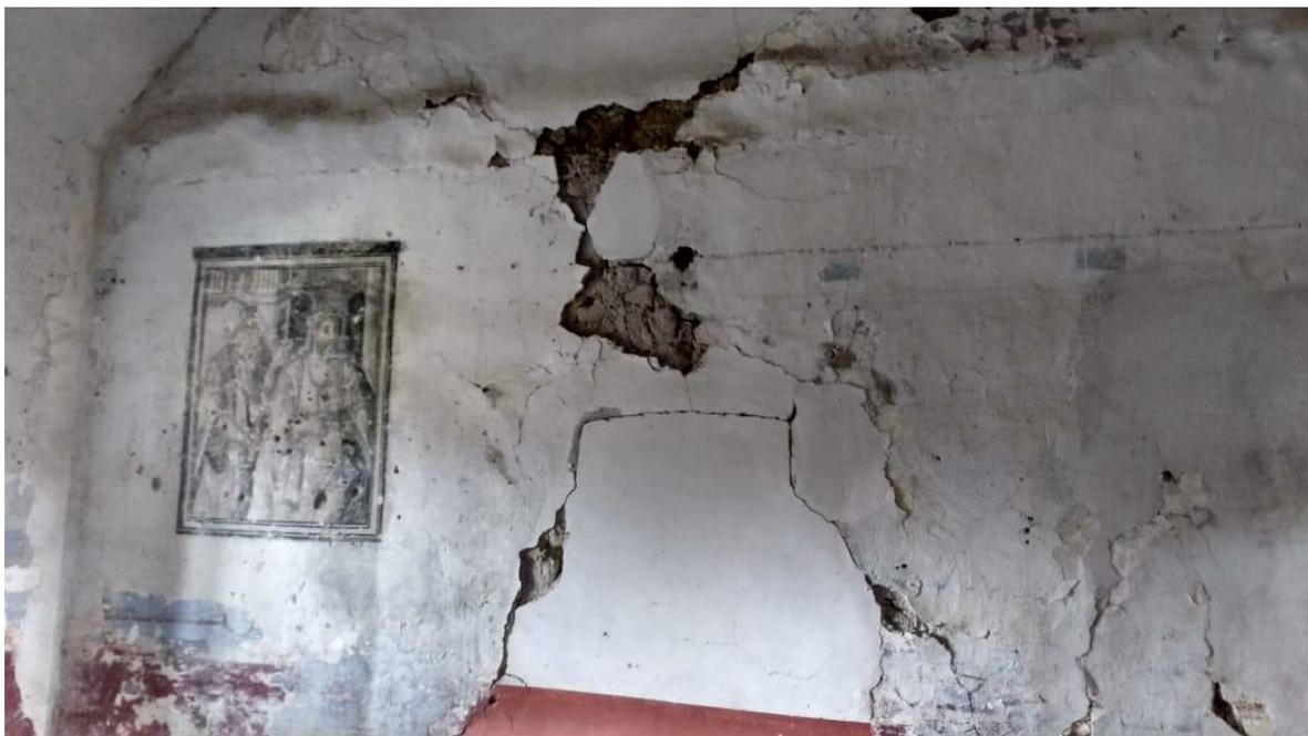
Imagen 324. Humedad, fisuras y desprendimiento de aplanado en muro, 2017.
