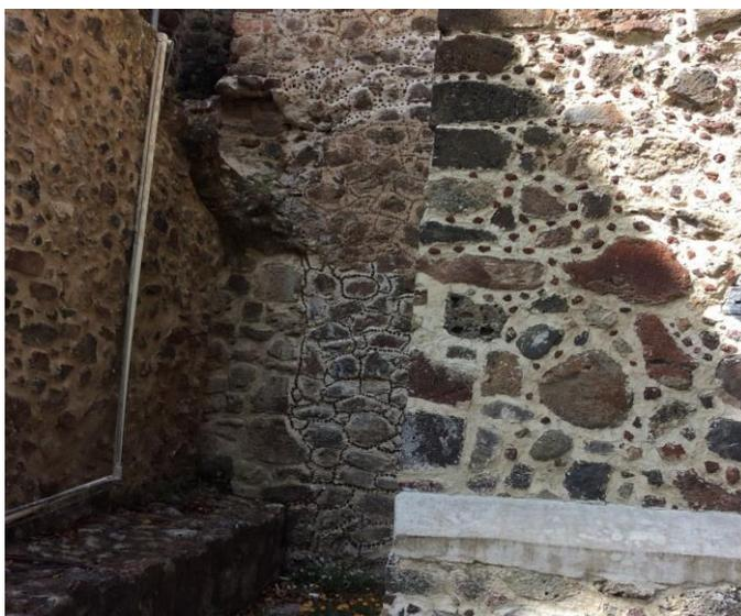
Imagen 265. Arranque de muro adosado al muro norte del convento, unión con el muro oriente del templo, San Guillermo, Totolapan, Mor., 2014.
