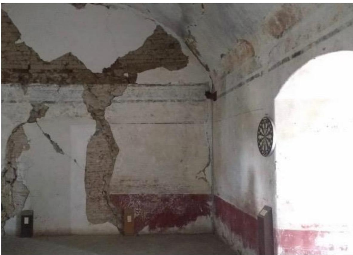
Imagen 325. Fisuras y desprendimiento de aplanado en muro en la sala de estar, 2017.
