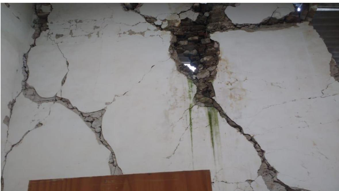
Imagen 321. Fracturas y grietas en muro de dormitorio, 2017. Foto. Laura Moyers Ruíz.
