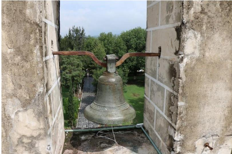
Imagen 284. Perforaciones en los muros de la espadaña para colocar elementos de fierro forjado para colgar la campana, 2014. Foto. Laura Moyers Ruiz.
