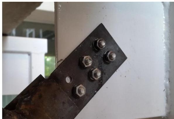
**Figura 3.9** Conexión marco-contraventeo.
