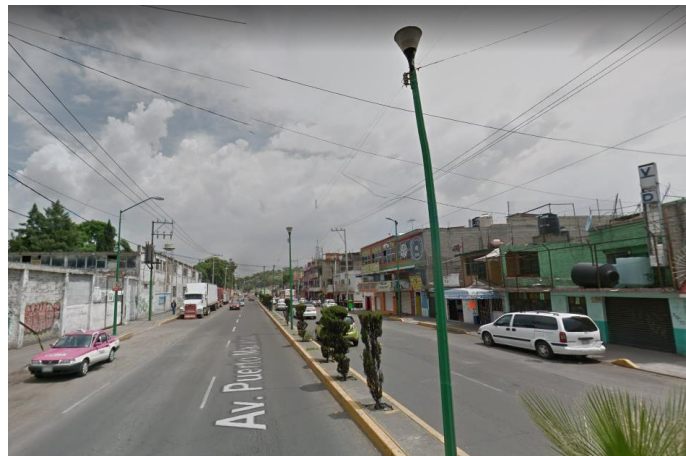
➤ Alumbrado público sobre Av. Puerto Mazatlán.
