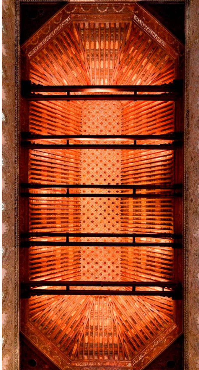
Fig. 42. Cubierta de par y nudillo de la sinagoga del Tránsito o Santa María la Blanca, Toledo, España. (Fotografía de David Blázquez). Tomada de http://www.turismocastillalamancha.es/patrimonio/museo-sefardi-sinagoga-del-transito-2264/descripcion/
