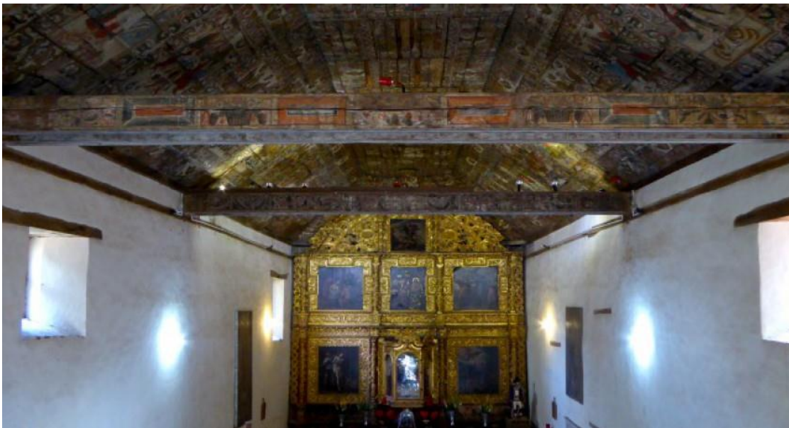
Fig. 44. Cubierta de par y nudillo de Santiago Apóstol de Tupátaro, Michoacán. Tomado de http://michoacan.travel/es/lugares/iglesia-de-santiago-apostol-tupataro.html
