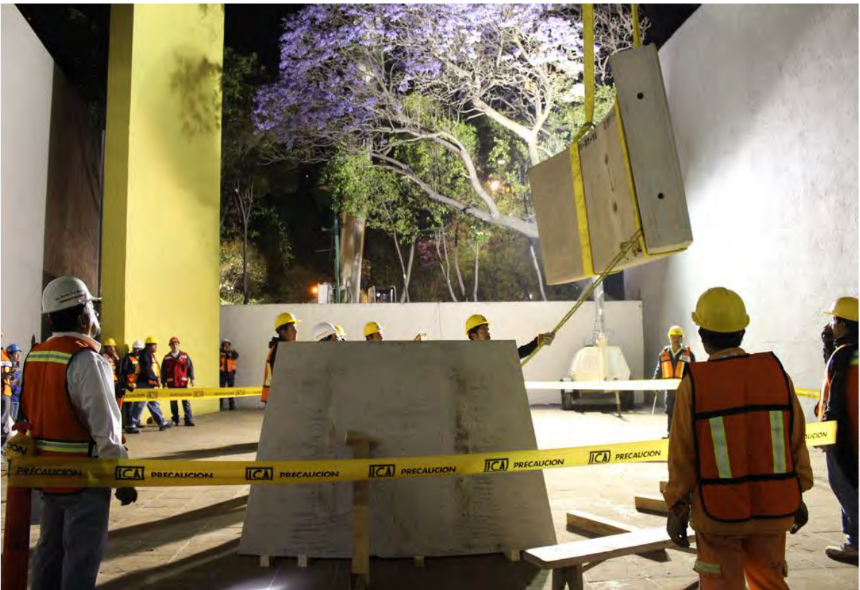
Trabajos de instalación de 'Paradoja Hídrica', proyecto ganador de 'Pabellón Eco' 2015. Créditos: Museo Experimental El Eco. 98.
