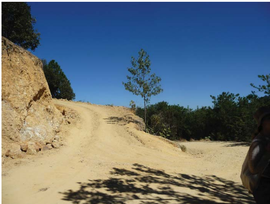
Fotografía, rampas de acceso a la colonia 16 de Septiembre, Rogelio Arreola
