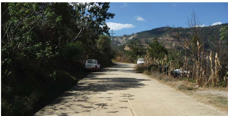
Fotografía, tramo de concreto en el acceso al centro de la comunidad, Rogelio Arreola
