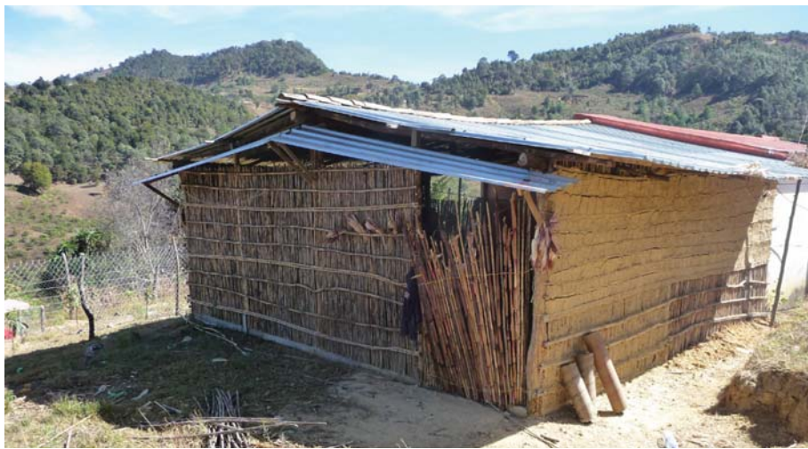
Fotografía, vivienda construida bajareque y adobe, Rogelio Arreola
