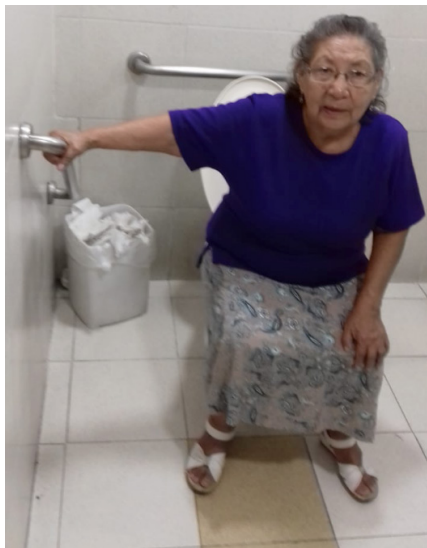
Imagen 3.7 Fotografía tomada en el sanitario para discapacitados del centro comercial Walmart ubicado en Av. Cuhutlahuac CDMX.
