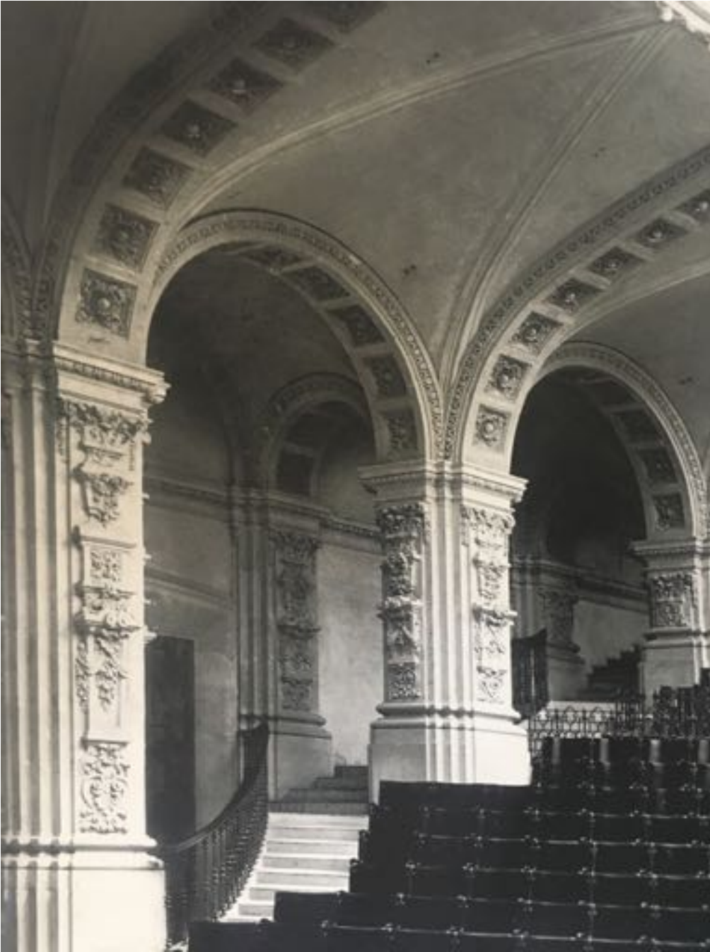
Fig. 68. Ornamentación de las pilastras y arcos que sostienen la bóveda del Anfiteatro. Diseño de Samuel Chávez.
