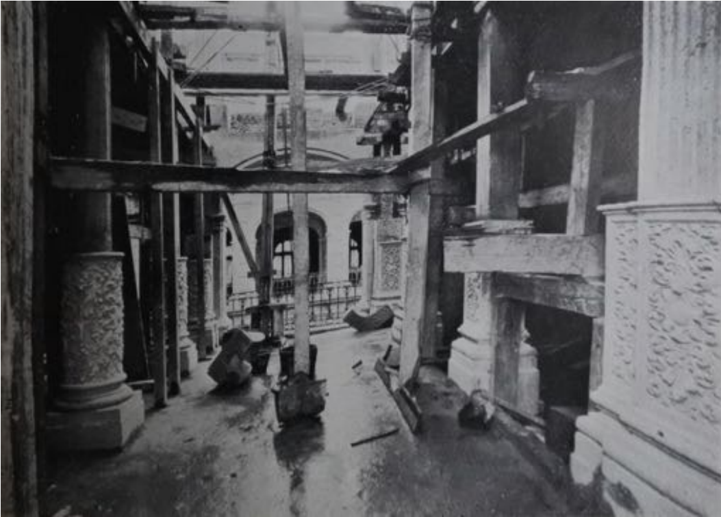
Fig. 70. Sillares labrados usados como encofrados del sistema Hennebique. Diseño de Samuel Chávez.
