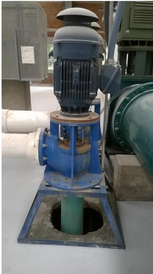
Fotografía 1.10 Bomba con velocidad de operación de diseño de 1700 rpm
