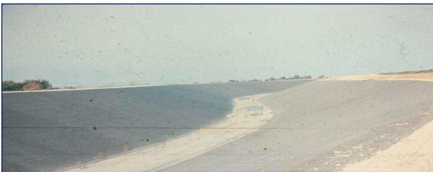
Figura 4.13.- Canal Independencia (antes Alimentador del Norte) en proceso de terminación.
