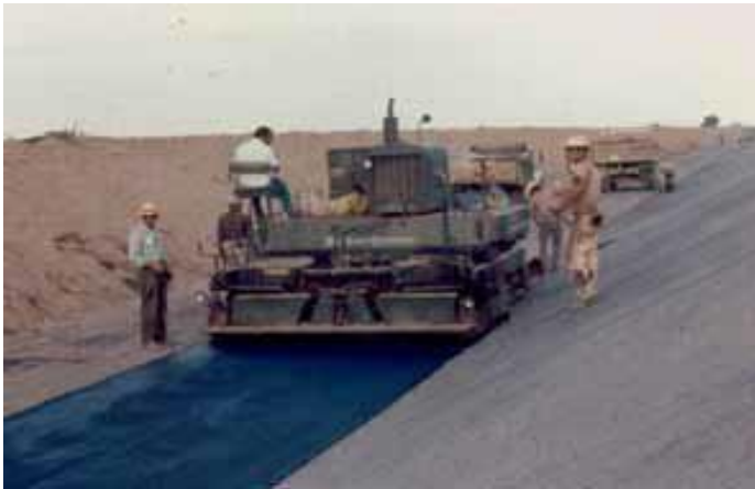
Figura 4.11.- Máquina que extiende el concreto asfáltico
