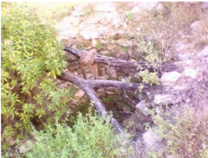
Figura 27: Pozos, kuneb, en el camino de San Pedro a La Compuerta que están abandonados y secos en diciembre 2016
