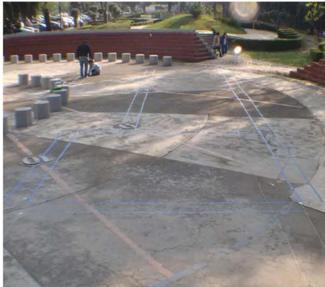
< Figura 2.44: Preparación para la instalación del dispositivo. Fuente: Díaz, Gabriela. 2016.
