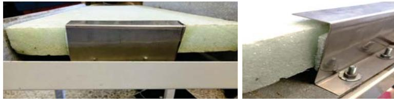
Figura 3.23: Sujeción del aislante térmico.
