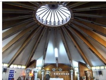
Vista de la cubierta
