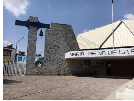
Vista del atrio, acceso y campanario
