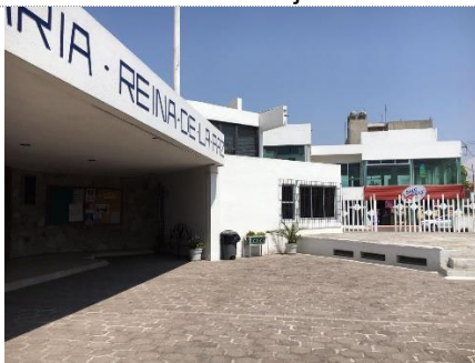
Vista de la zona de criptas
