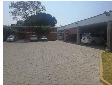
Vista hacia salón de usos múltiples y capilla adoración perpetua
