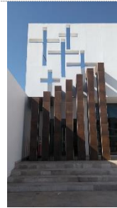
Detalle que enmarca el acceso
