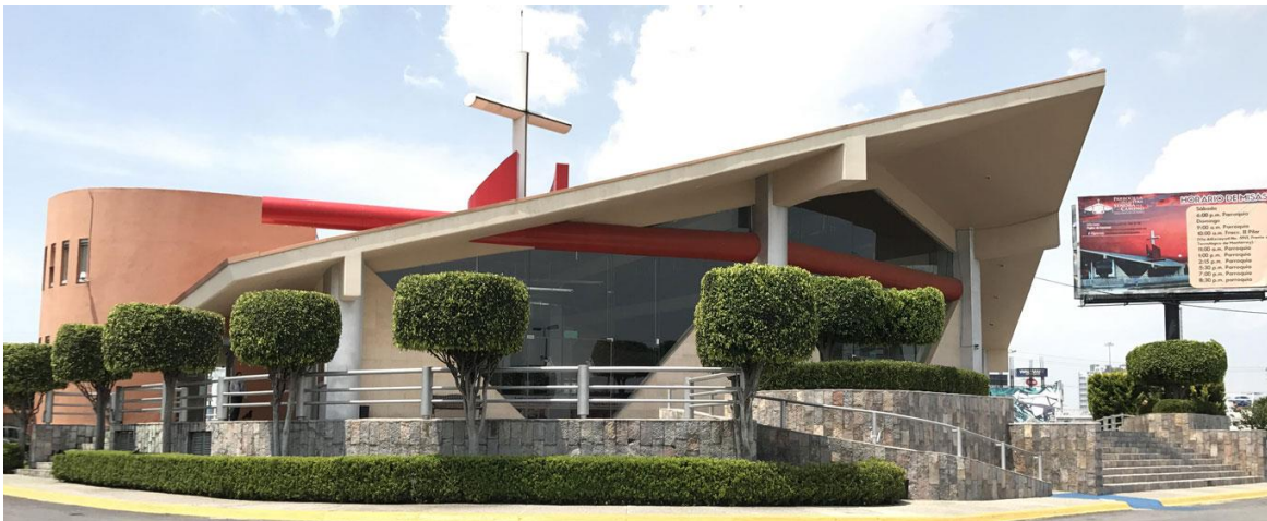
Foto 46: Fachada principal Foto: Juan Pablo Méndez Aguilar
