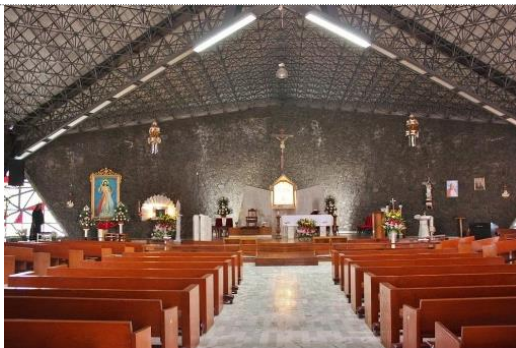
Vista de la nave hacia presbiterio
