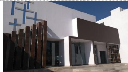
Vista del acceso
