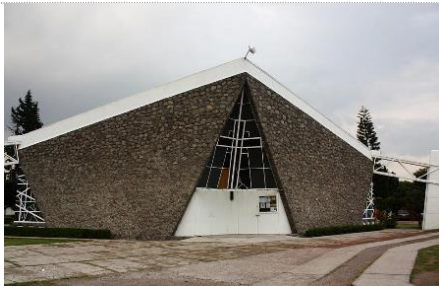
Vista del acceso
