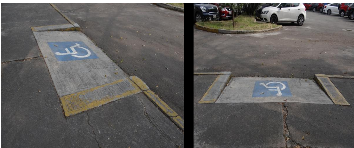
Foto 5. Dos de las rampas de los Estacionamientos.
