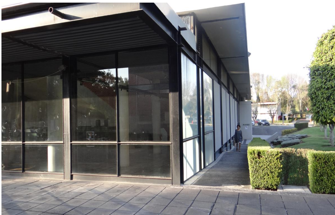
Foto 21. Rampa de acceso al Centro Cultural.
