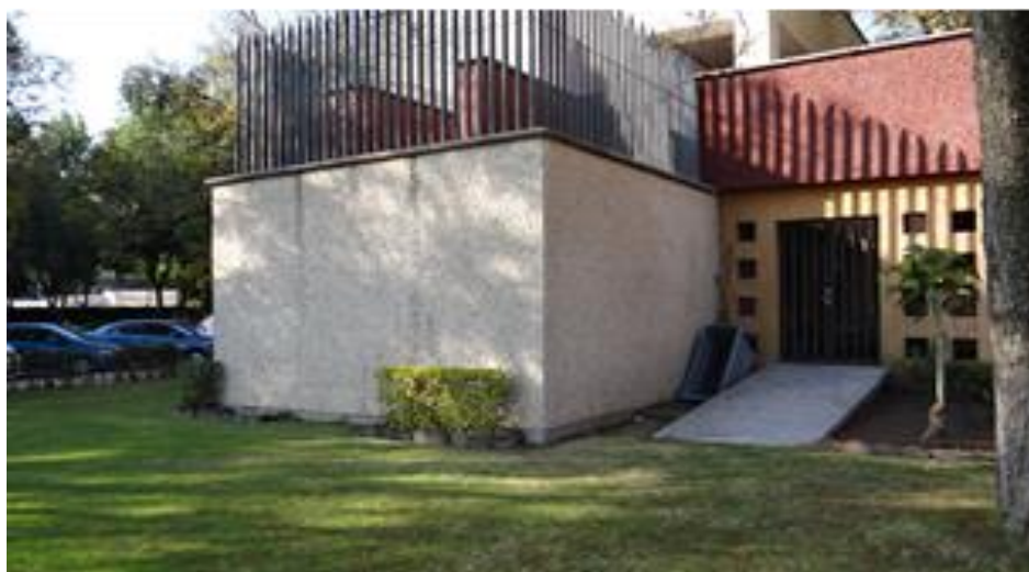
Foto 7. Rampa de acceso a la Unidad de Seminarios.
