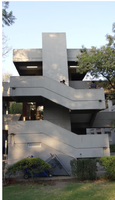
Foto 29. Escaleras de concreto.
