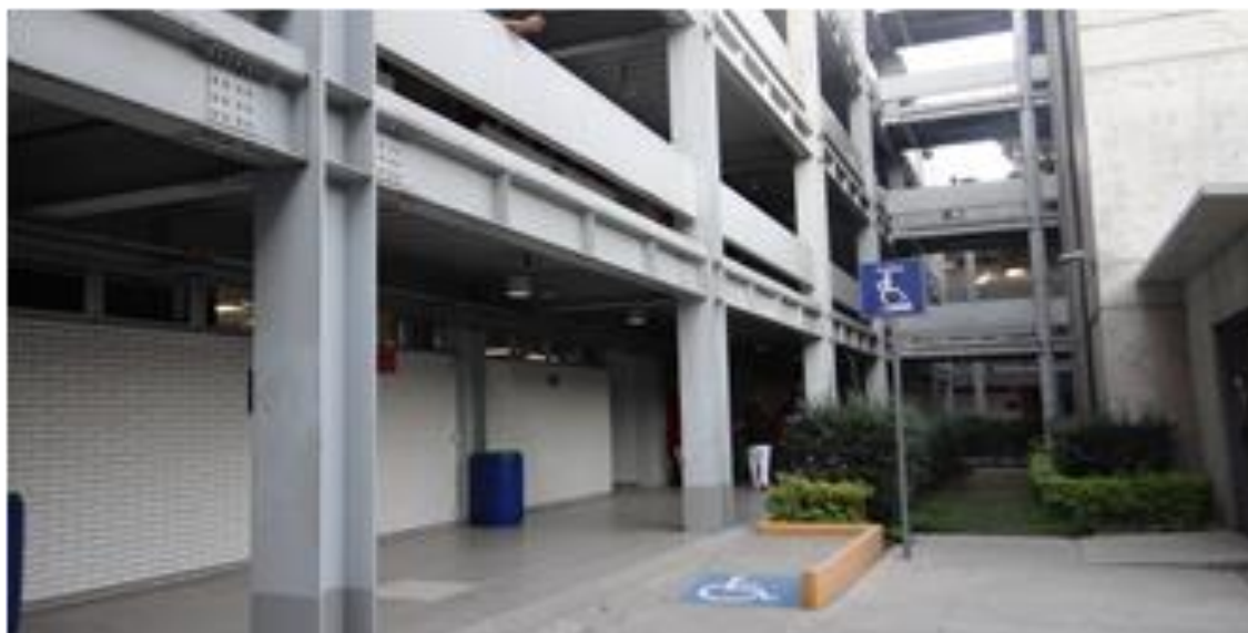
Foto 31. Rampa para silla de ruedas a un costado del Edificio A4.
