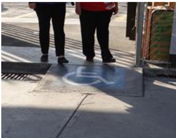
Foto 2. Rampa para silla de ruedas.
