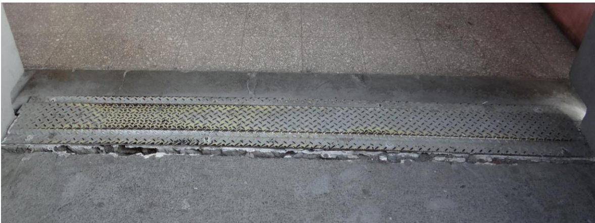
Foto 32. Unión de metal entre edificios.
