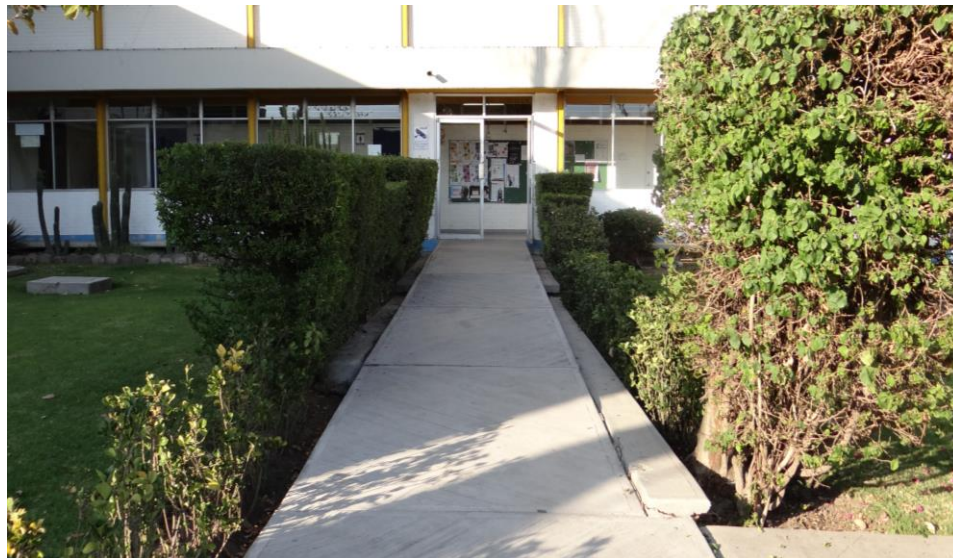
Foto 17. Rampa de Acceso a la CUSI, desde el estacionamiento.
