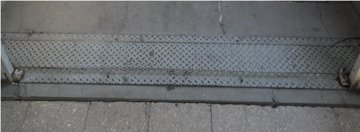
Foto 31. Unión de metal entre edificios.
